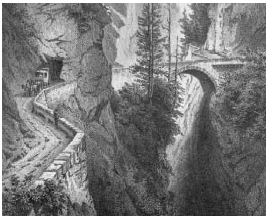
Die Kunststrasse von 1823 in der Viamala La strada artificiale nella Viamala prima del 1823
