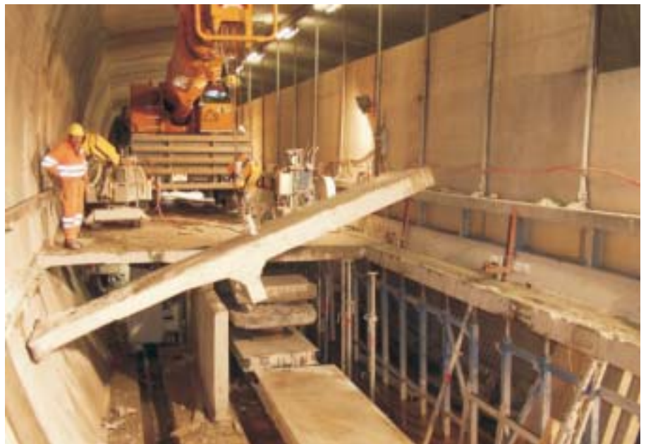
Abbruch der alten Fahrbahnplatte Smantellamento della vecchia piattabanda
