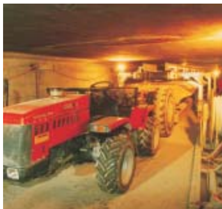
Abtransport des Sohlenausbruches Rimozione del materiale di scavo
