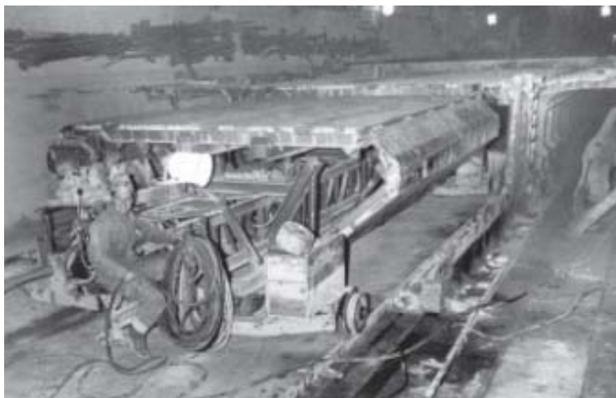
Die damals moderne Schalung für den Bau der Fahrbahnplatte La cassetta allora moderna per la costruzione della piattabanda
