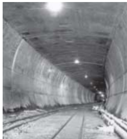
Das Tunnelgewölbe vor Einbau der Fahrbahnplatte La volta della galleria prima dell'installazione della piattabanda
