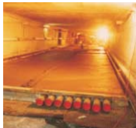
Kabelschutzrohre in der Stollensohle Canali di condotta nel nuovo fondo
