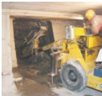
Ausbruch des Fluchtabganges Scavo del passaggio di fuga
