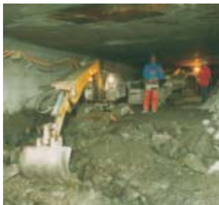
Sohlenausbruch unter beengten Verhältnissen Scavo difficile del fondo
