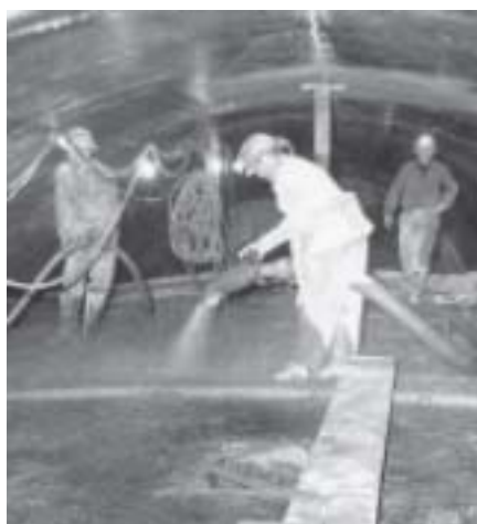
Betonieren der Zwischendecke Getto di calcestruzzo del soffitto intermedio
