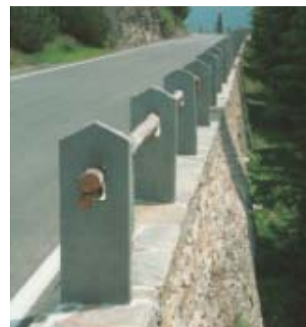
Mauerkrone mit Steinpfosten Corona murale con montanti in pietra
