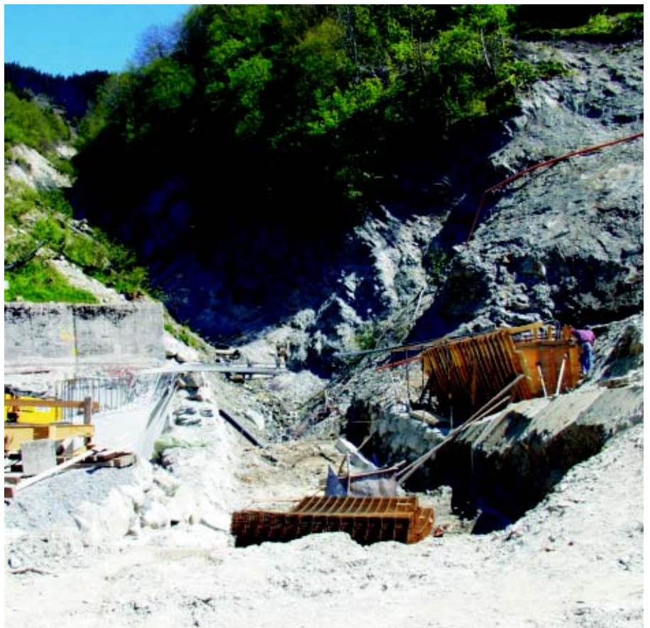
Die Wiederherstellungsarbeiten an der Schlanserstrasse im Val Fabertg
