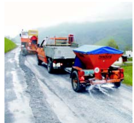
Unterhalt auf einer Naturstrasse
