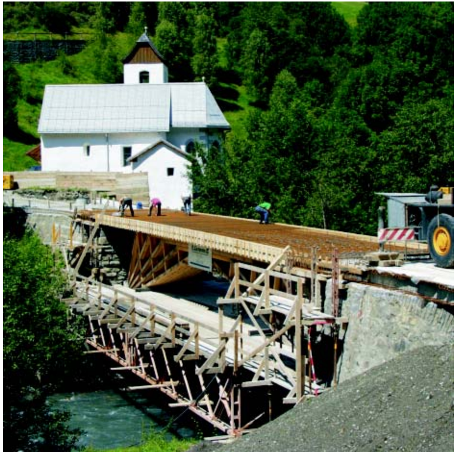
Die mit dem Holzbaupreis 2004 ausgezeichnete Glennerbrücke Peiden Bad im Bau
