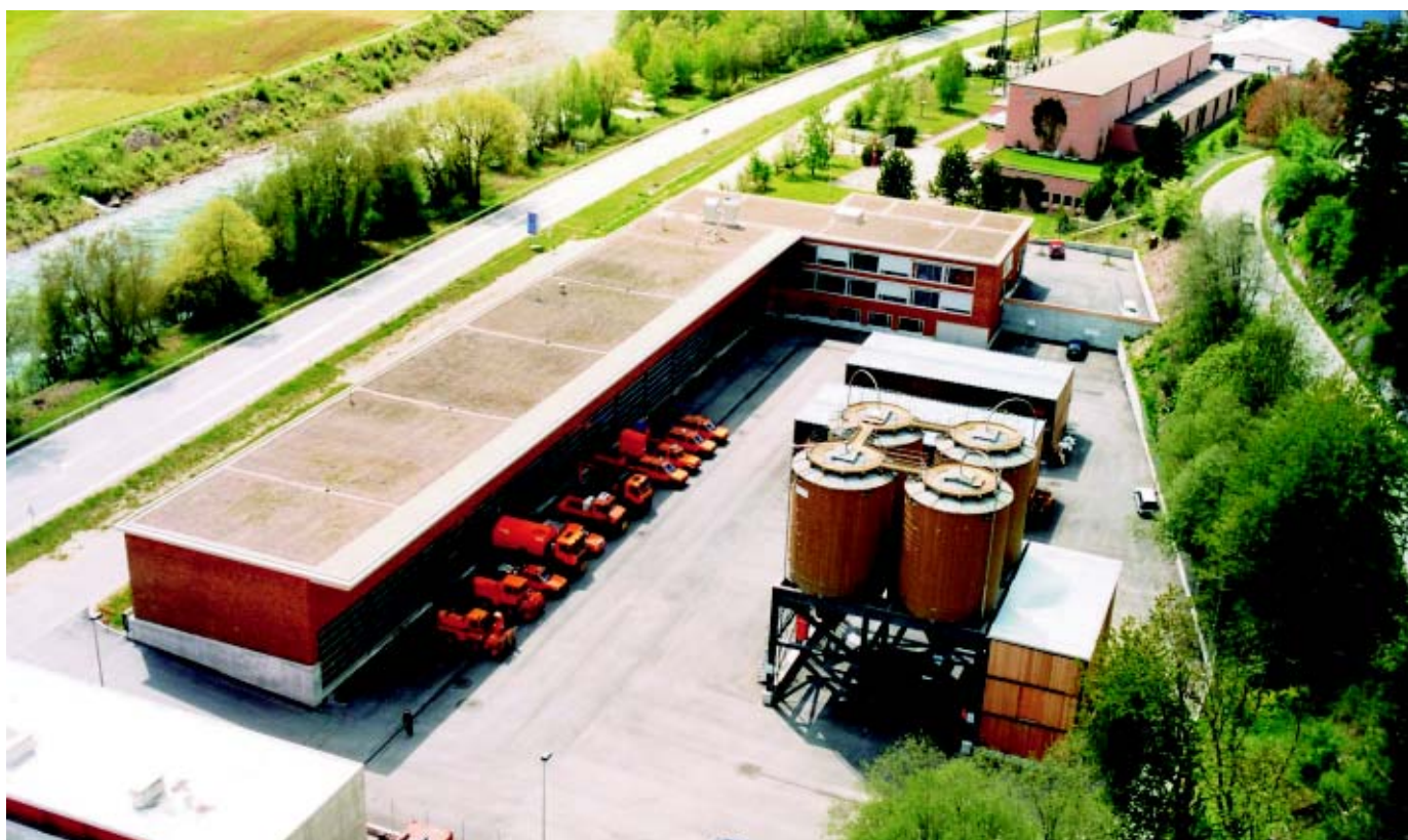
Der kantonale Werkhof in Ilanz mit den Garagen, Lagern und Büroräumlichkeiten des Bezirks 6 des Tiefbauamtes Graubünden
