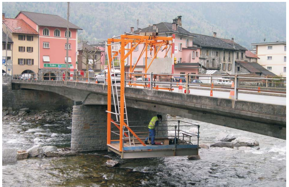
Montage des Überwachungssystems an der Ponte Moesa
