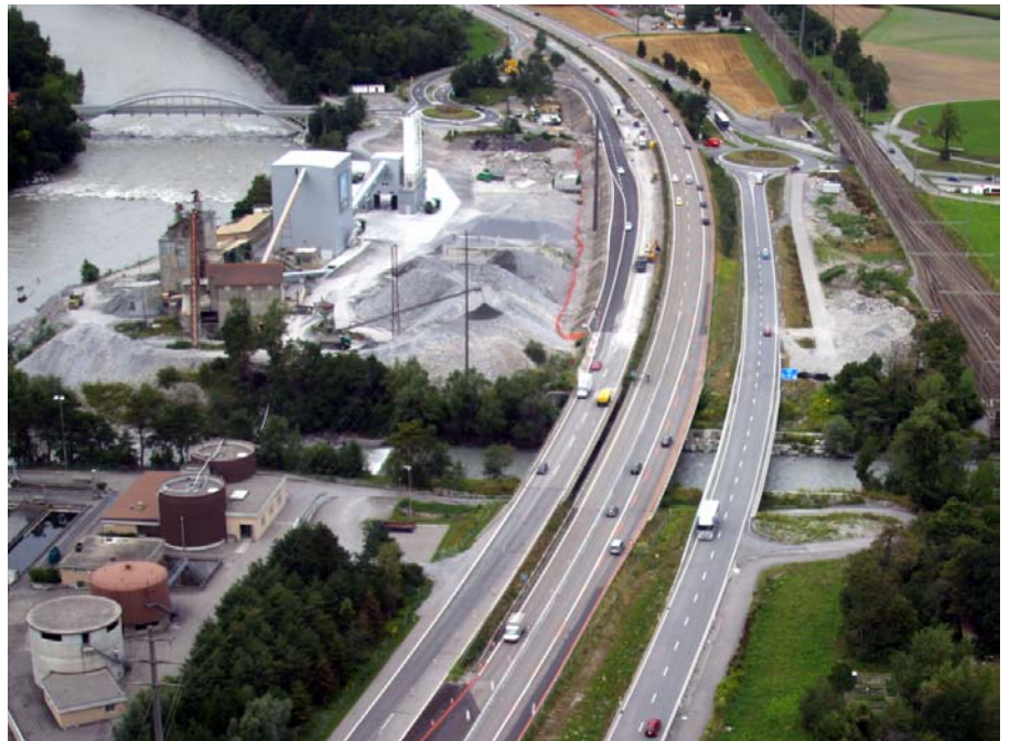
Der A13-Anschluss Landquart mit der neuen Tardisbrücke und der verbesserten Einfahrt Richtung Chur; im unteren Bildteil die drei Landquartbrücken, von denen die linke diesen Herbst abgebrochen und bis im Sommer 2005 neu erstellt wird.
