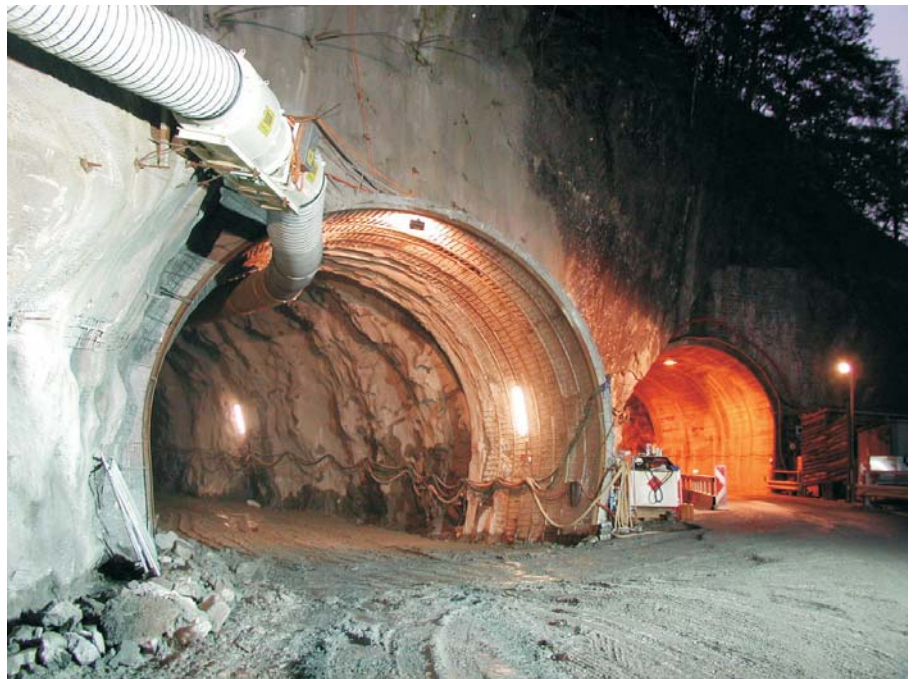
Portale sud della nuova Galleria Val d'Infern (lunghezza ca. 280 m), a destra il portale della vecchia galleria. Das Südportal des neuen ca. 280 Meter langen Umfahrungstunnels, rechts der alte Tunnel.
