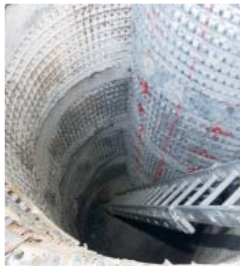
Blick in den 10 m tiefen Fundationsschacht
