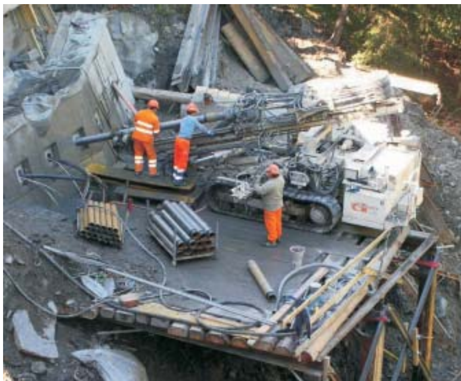
Bohren und Einbau der Bodenanker im steilen Gelände unterhalb des westlichen Widerlagers der Caselertobelbrücke
