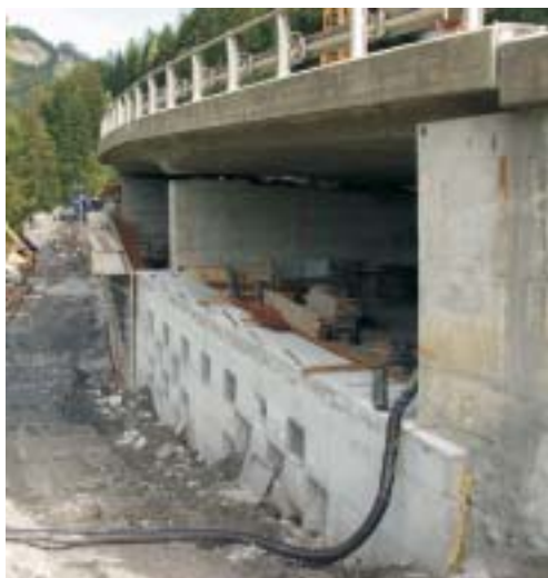
Ankerriegel der Hangbrücke vor Ankereinbau
