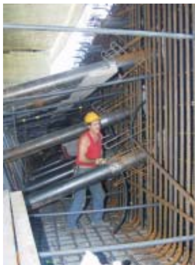
Armieren des Ankerriegels
