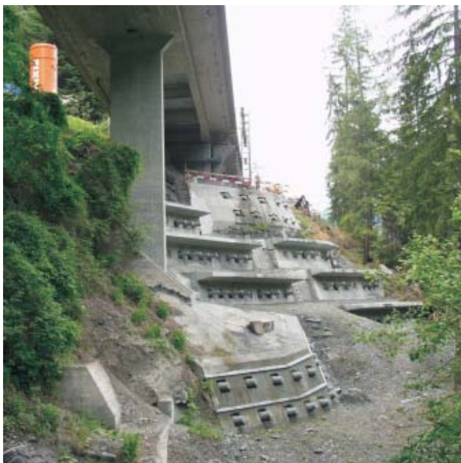
Die neuen Verankerungen unter dem westlichen Widerlager der Caselertobelbrücke drücken mit 7'000 Tonnen gegen die Rutschmasse.
