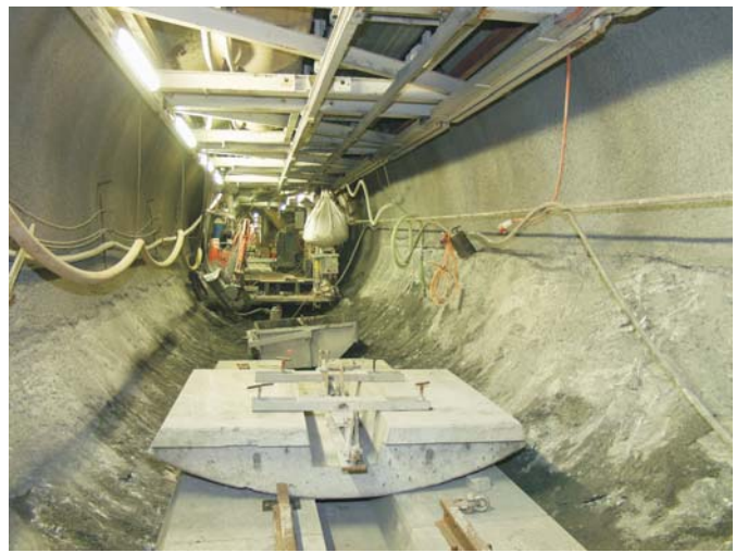
Versetzen der Sohlübbinge
