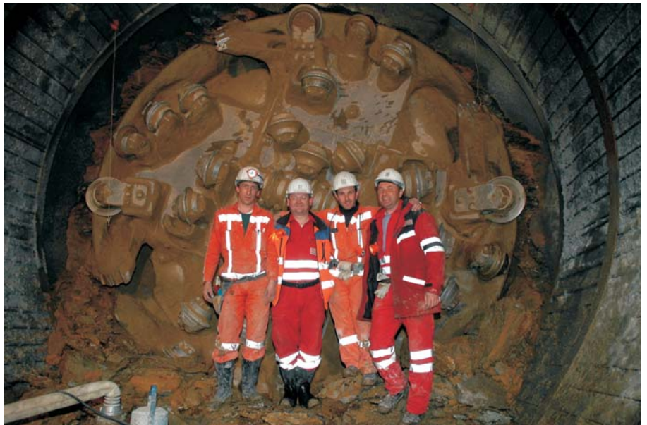
Die Mineure feiern den erfolgreichen Durchschlag im Sicherheitsstollen
