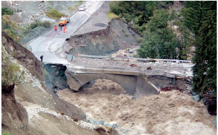
Brücke Tasna: Sicherungs- und Aufräumarbeiten beim Unwetter im August 2005
