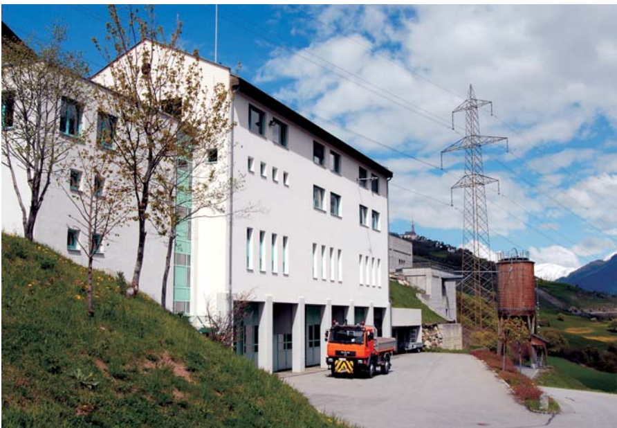
Der Werkhof des Bezirks 4 des Tiefbauamtes Graubünden in Scuol
