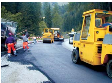
Sanierung eines Asphaltbelages
