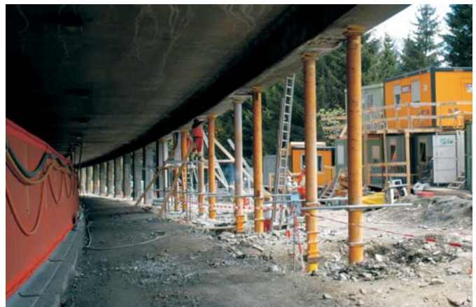
Provisorische Abstützung des Galeriedaches Seda
