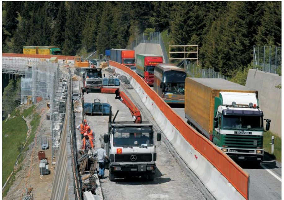
Instandsetzungsarbeiten an der Stützmauer Salvanei unter einspurigem Verkehr
