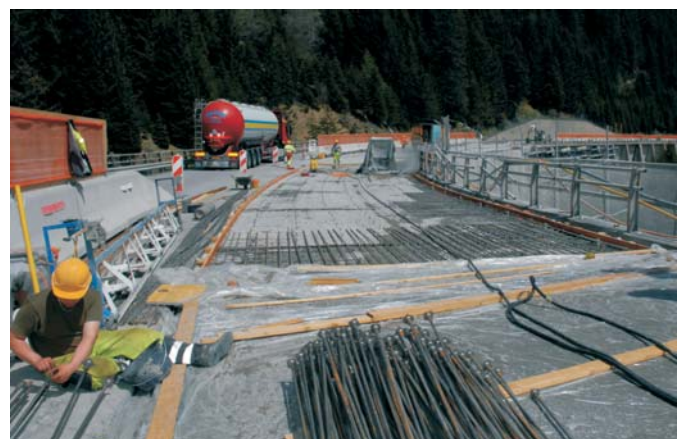
Instandstellung der Armierung der Fahrbahnplatte Salvanei
