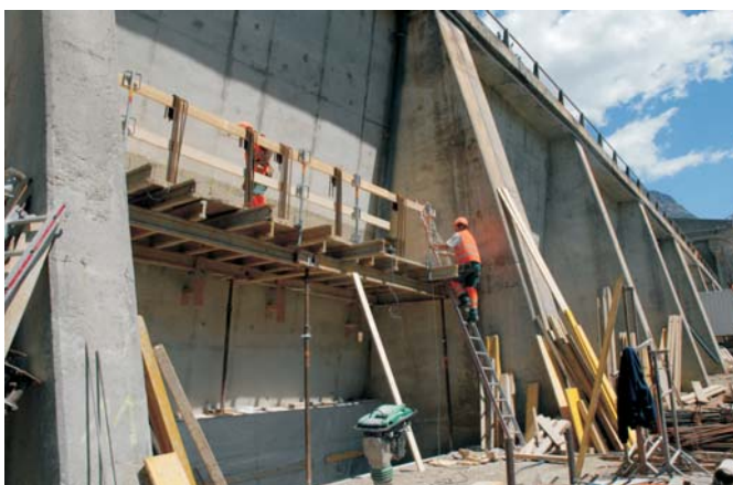
Verstärkung der grossen Stützmauer Salvanei
