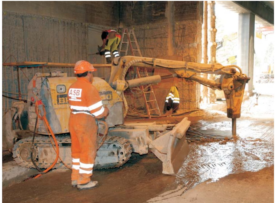
Ausbrucharbeiten im Tunnel Land für die Entwässerung im Trennsystem
