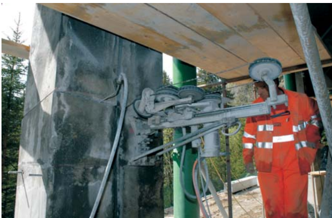
Durchtrennen der Betonstützen mit einer Diamantseilsäge
