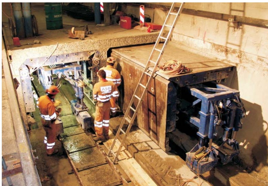
Ausfahren und Richten der Stahlschalungen für eine neue Betonieretappe Spostamento e aggiustamento dei casseri per una nuova tappa di costruzione
