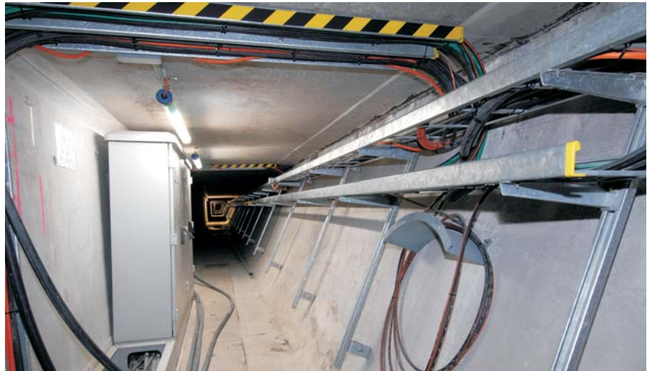
Le nuove condotte con i cavi sotto la piattabanda della carreggiata Die neue Verkabelung unter der Fahrbahnplatte
