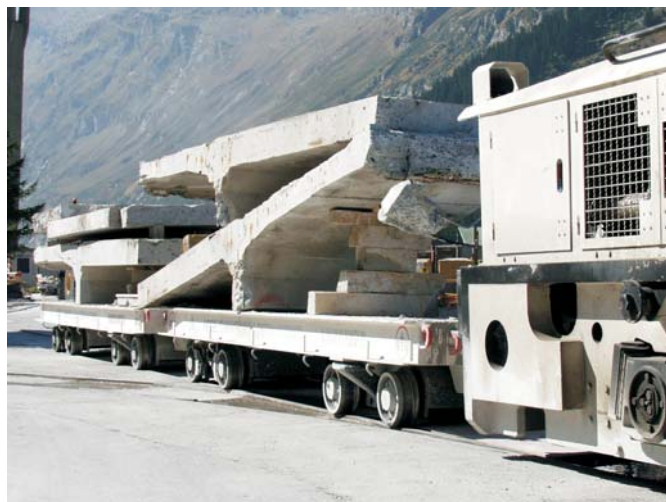
Abtransport der alten Fahrbahnplatte mit der Stollenbahn Rimozione della vecchia piattabanda tramite trenino di cantiere
