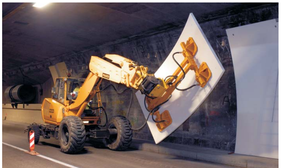
Montaggio dei nuovi pannelli in calcestruzzo alle pareti Versetzen der neuen Wandplatten aus hochfestem Beton
