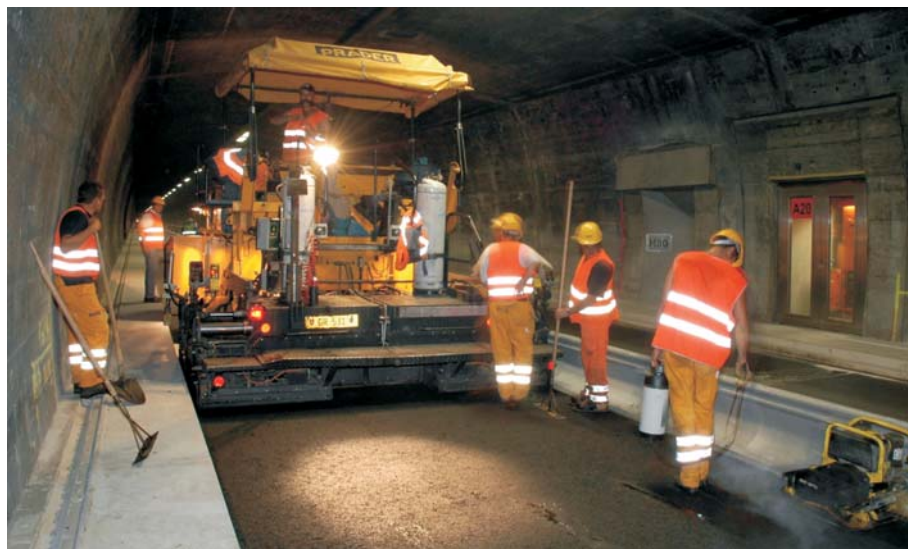
Posa della pavimentazione in miscela bituminosa Einbau des Fahrbahnbelages aus Asphaltbitumen
