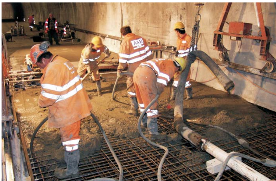
Betonieren der neuen Fahrbahnplatte mit Pumpbeton Getto del calcestruzzo della nuova piattabanda mediante pompa
