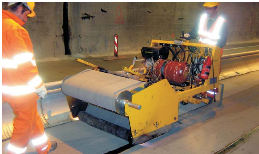
Impermeabilizzazione della piattabanda con guaina in bitume Abdichten der Fahrbahnplatte mit einer Bitumenfolie
