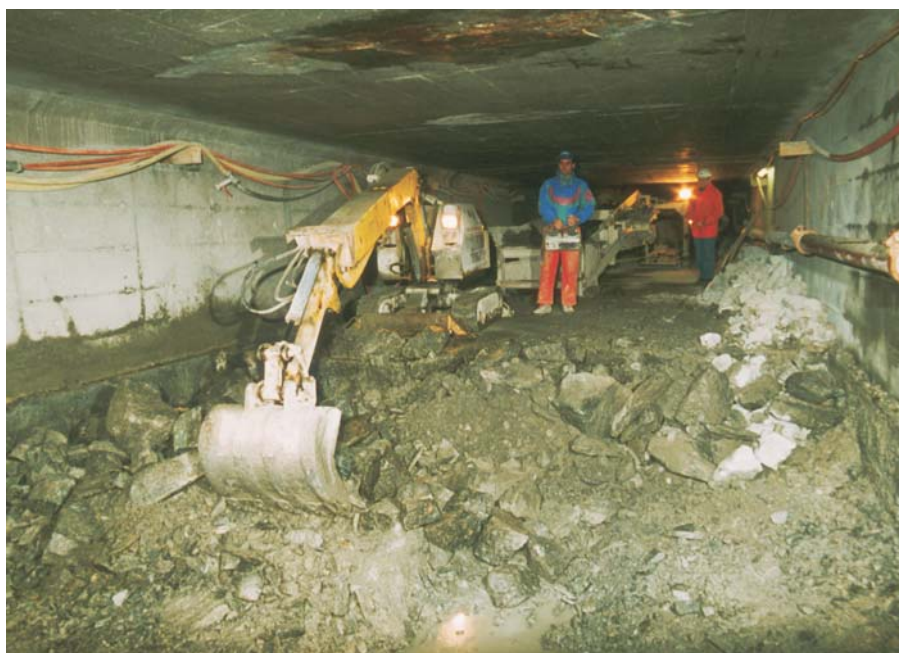
Abtiefen des ursprünglichen Belüftungsstollens für den Flucht- und Rettungsstollen Abbassamento del suolo nella vecchia condotta d'aerazione per i nuovi cunicoli
