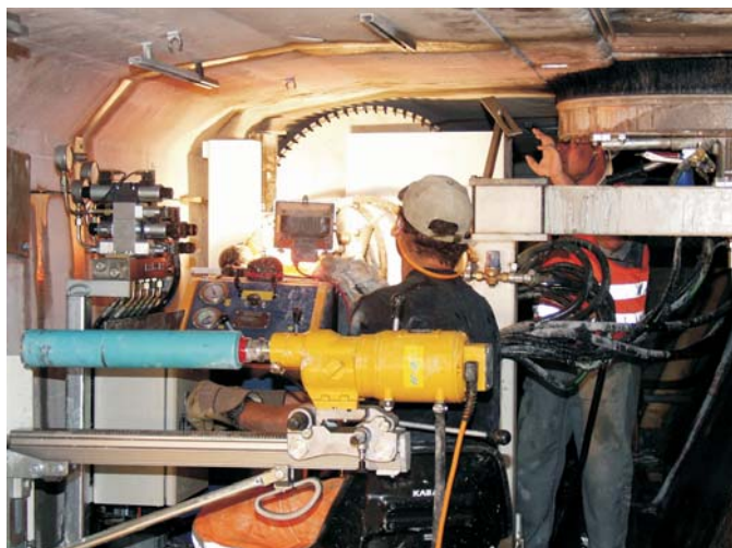
Zerlegen der alten Betonplatte mit einer Fräse im Abluftstollen Smantellamento della vecchia piattabanda mediante fresatura
