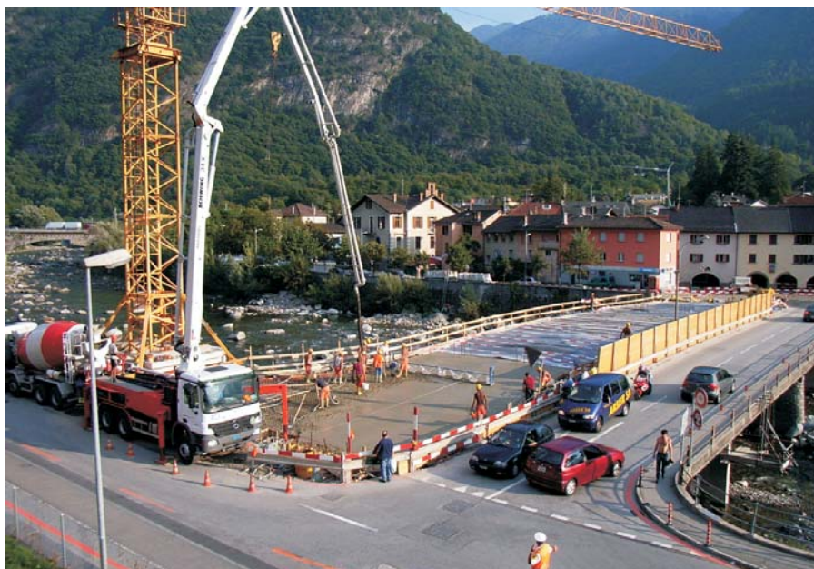
Getto del calcestruzzo della piattabanda
