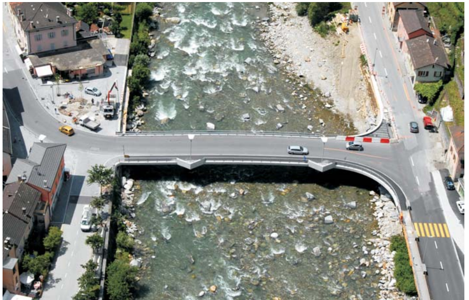
Il nuovo ponte sopra la Moesa a Roveredo
