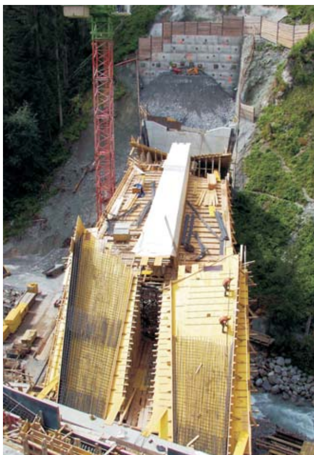
Schalen und Armieren der Schrägstützen
