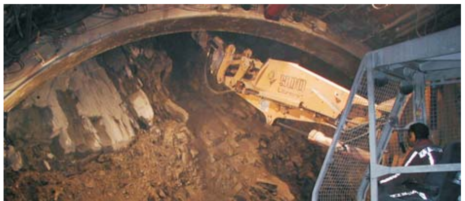
Sprengvortrieb im Quintnerkalk (oben), Messerschildvortrieb im Bergsturzmateriel
