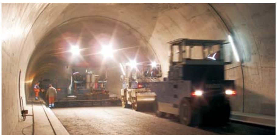
Baumeisterarbeiten im Tunnel: Ausbruch des Tunnels, Abdichten gegen Bergwasser, Betonieren der Zwischendecke, Einbau des Fahrbelages.
