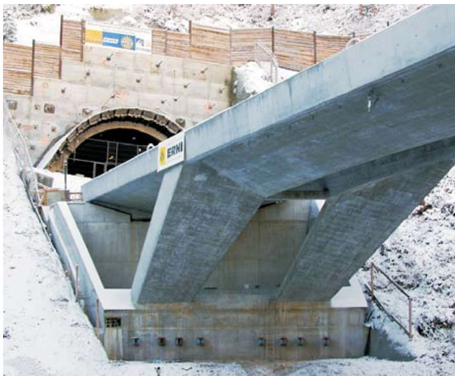
Die in die steile Hangflanke eingepasste Widerlagerkonstruktion und die unkonventionell geformten Sprengwerkstützen
