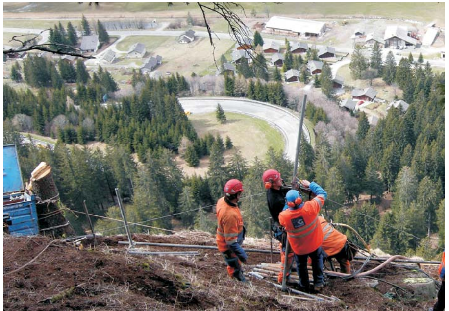
Vorbereitungsarbeiten für den Sprengabtrag hoch über der Nationalstrasse A13 Lavori preparatori per la rimozione dei massi dopo il brillamento sopra la A13
