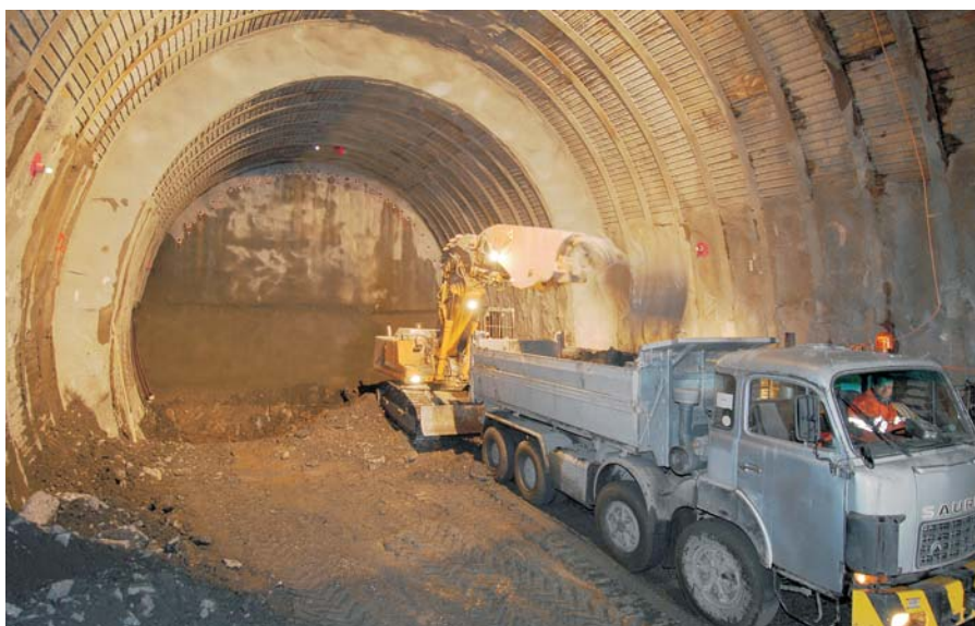
Abtransport des Ausbruchmaterials beim fallenden Vortrieb
