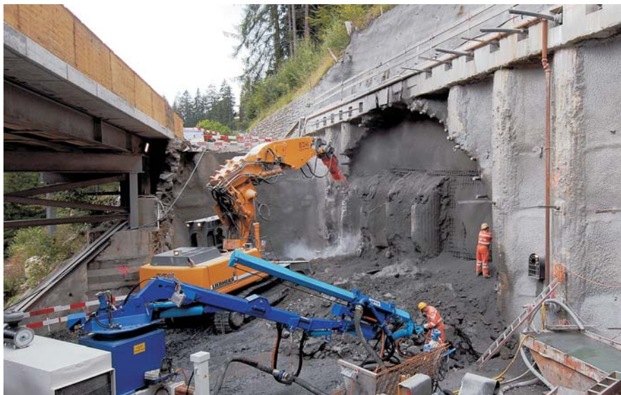
Arbeitsbeginn für den fallenden Vortrieb beim Ostportal
