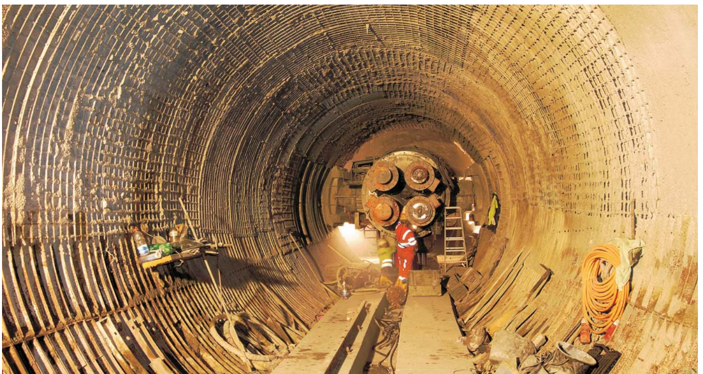
Demontage der Tunnelbohrmaschine am Ende des gefrästen Teils des Sicherheitstollens
