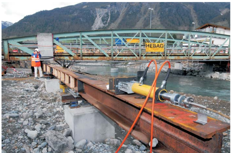
Verschubbahn mit Zuglitze und Schubpresse
