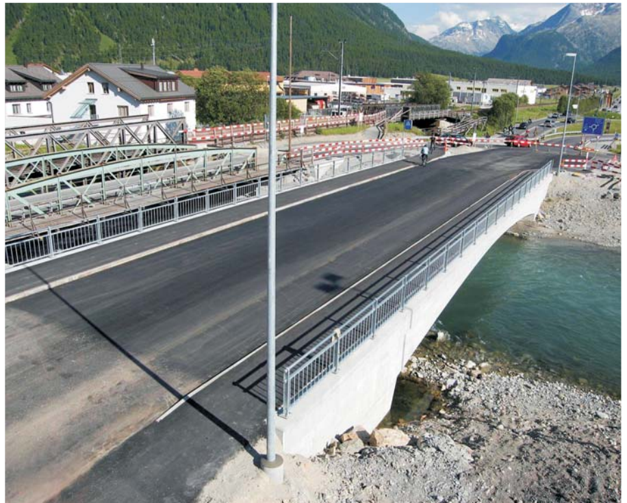
Die neue Innbrücke bei Samedan, links davon die alte Stahlbrücke vor dem Abbruch
