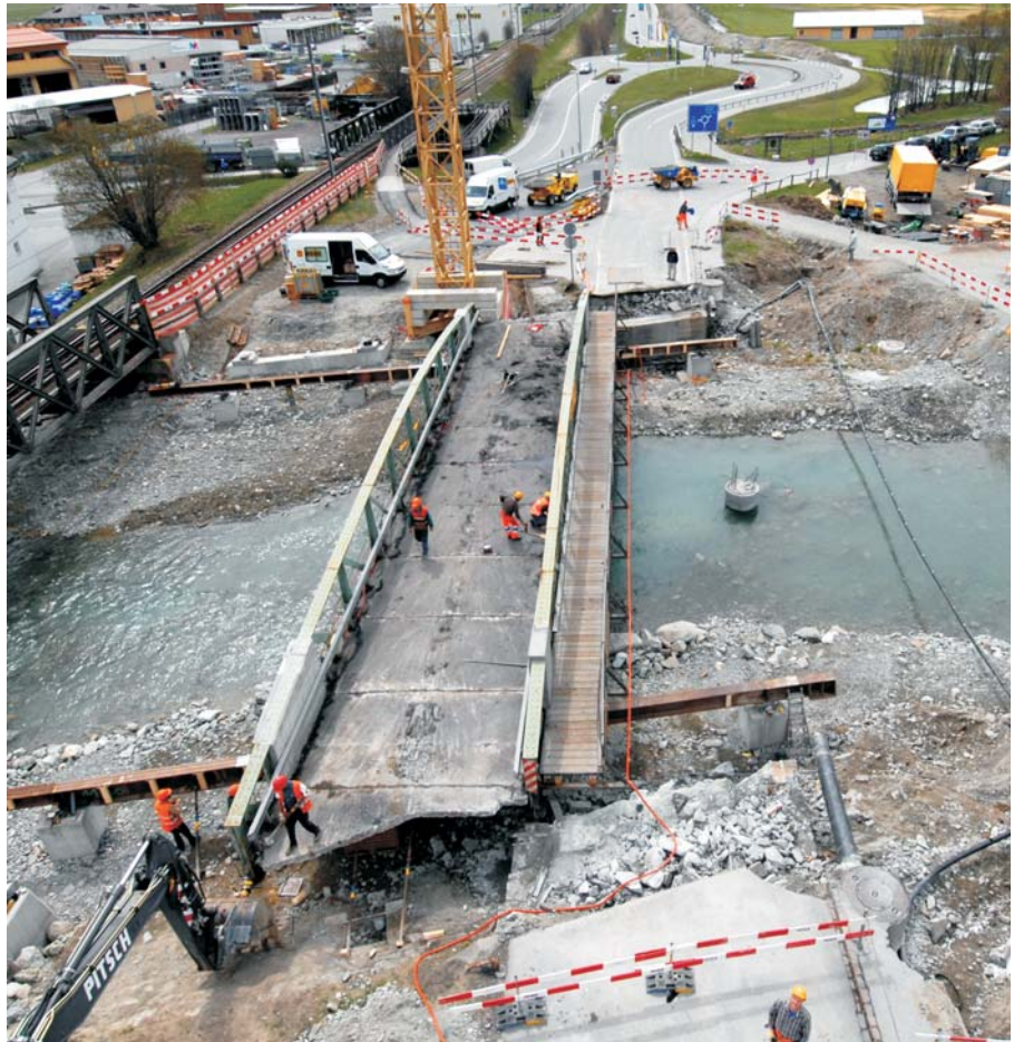
Verschiebung der Stahlbrücke aus der Strassenachse für den provisorischen Übergang
