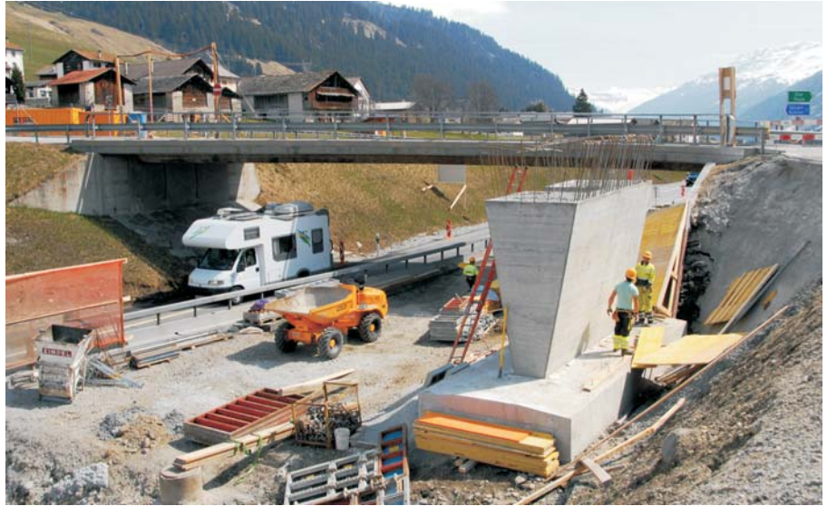
Bau der Widerlager für die neue Überführung beim Anschluss Nufenen
