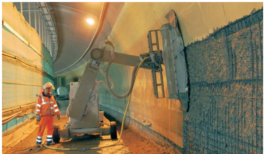
Abbau der schadhafte Betonoberfläche mit Wasserdruck
