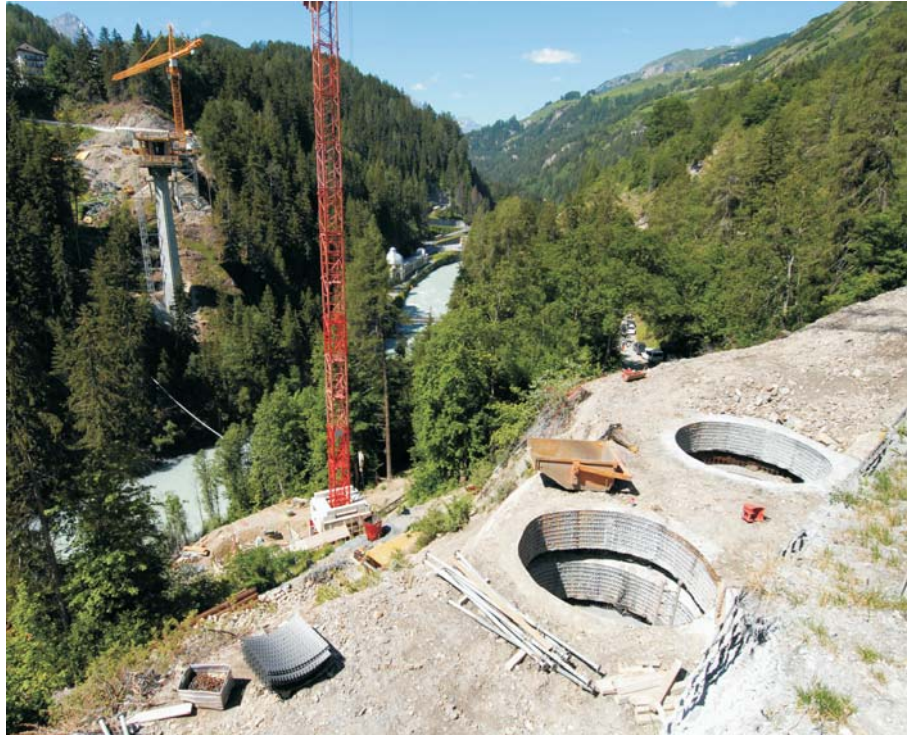
Im Vordergrund die Baugrube für die Fundation des Widerlagers beim Anschluss an die Engadinerstrasse, links im Hintergrund Pfeiler und Widerlager Seite Tarasp.
