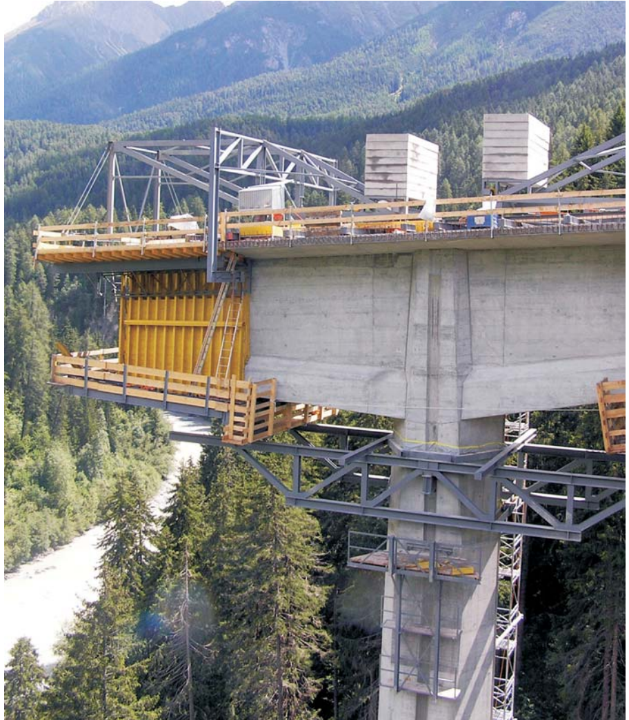
Der Freivorbau vom Pfeiler Tarasp in Richtung Pfeiler Scuol
