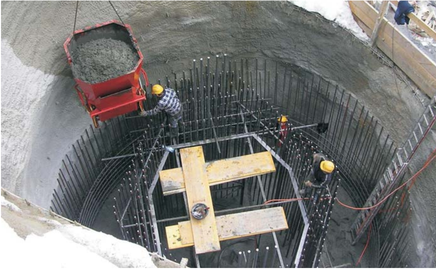
Betonieren der Fundamentplatte, in der Mitte die rhomboid angeordnete Anschlussbewehrung für den Pfeiler Tarasp
