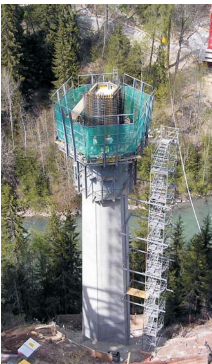
Bau des Pfeilers Tarasp
