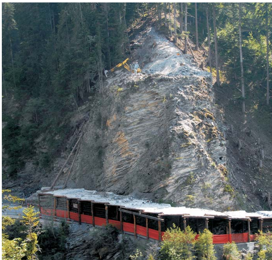
Abtrag des 40 Meter hohen Felskopfes eingangs des Steinbachtobels
