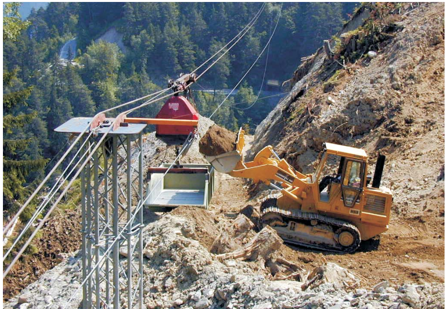
Eine Seilbahn transportierte die 45'000 Kubikmeter direkt aus dem steilen Hang zur Endlagerung in die Deponie Hof.
