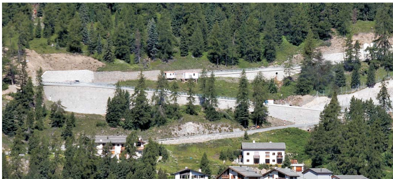
Ausbau der Wendekehren der Julierstrasse mit neuen Stützmauern in Bruchsteinmauerwerk, in Ergänzung zu den historischen Mauern aus den dreissiger Jahren.
