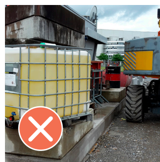
Manca la vasca di contenimento, ed il contenitore è troppo vicino alla macchina di cantiere
