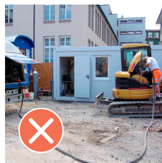
Tubo troppo lungo e senza protezione di sovrappassaggio. Il rifornimento non è effettuato da due persone
