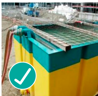
Bacino di decantazione con griglia, immissione delle acque prima della paratia
