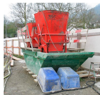
Esempio di lavaggio di contenitori al di sopra di una benna per il riutilizzo con un camion-betoniera
