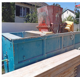
Esempio di vasca di lavaggio
