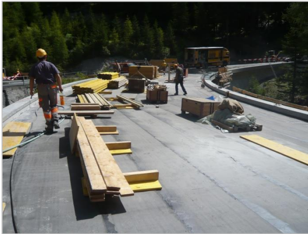
Materialdepots bzw. Parkflächen auf der eingebrachten Abdichtung
