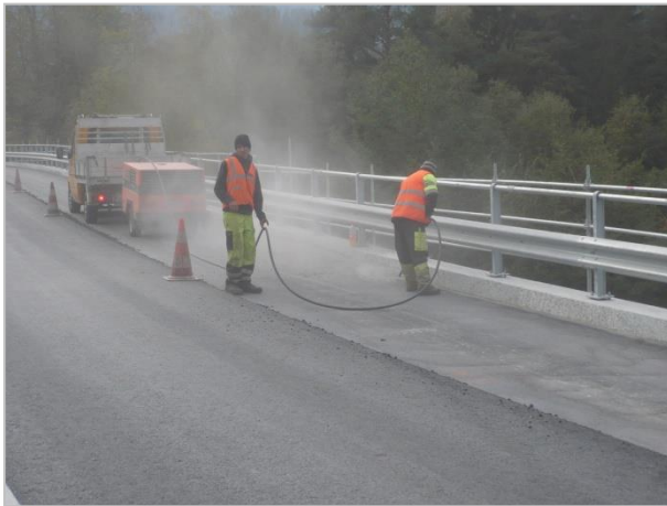
Reinigung der Abdichtung mit ölfreier Druckluft
