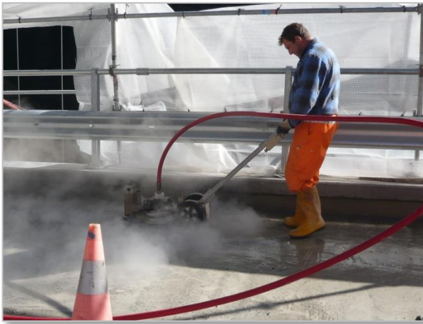
Entfernen der Zementhaut mittels HDW (750 bar)
