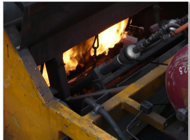
Flamme bei maschinellem Einbau
