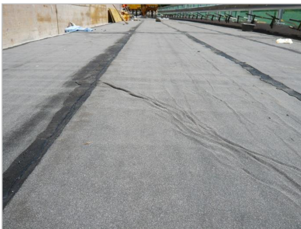
Auffalten der maschinell eingebrachten PBD- Abdichtung infolge Längsradius
