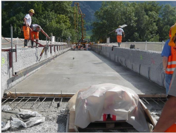
Reprofilierung mit Überbeton
