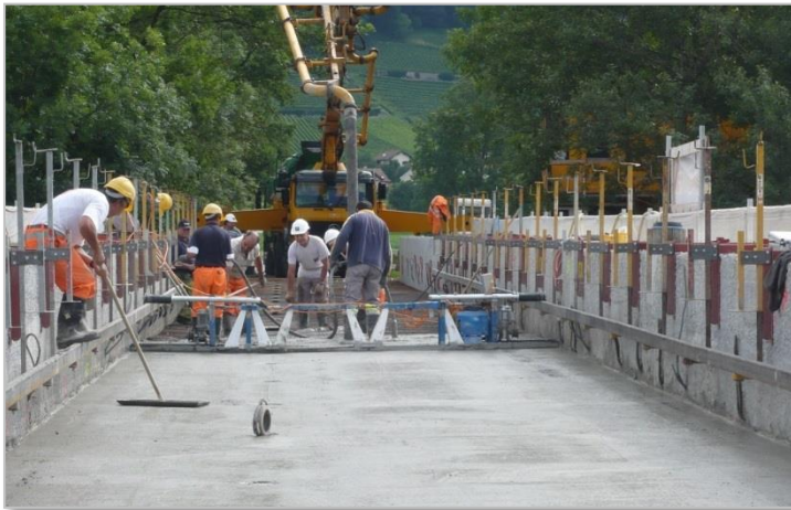
Nachverdichten und talochieren des frisch eingebrachten Fahrbahnbetons
