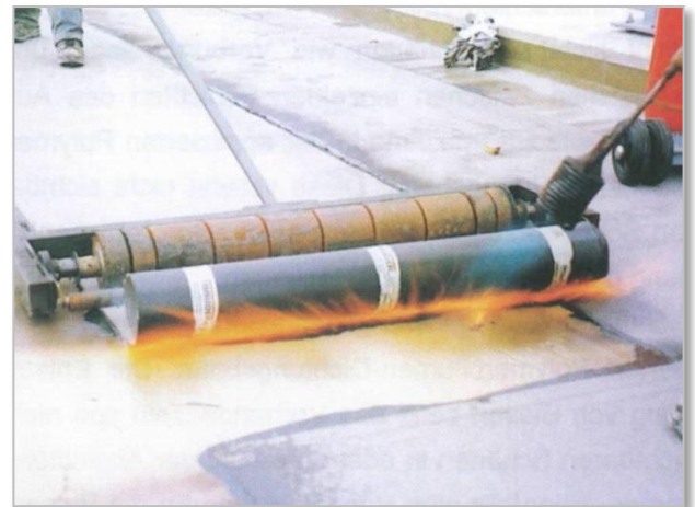
Vor dem Einbau müssen die Baderolen entfernt werden
