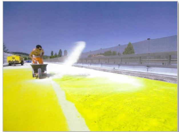
Abstreuen der Epoxidharzgrundierung mit Quarzsand
