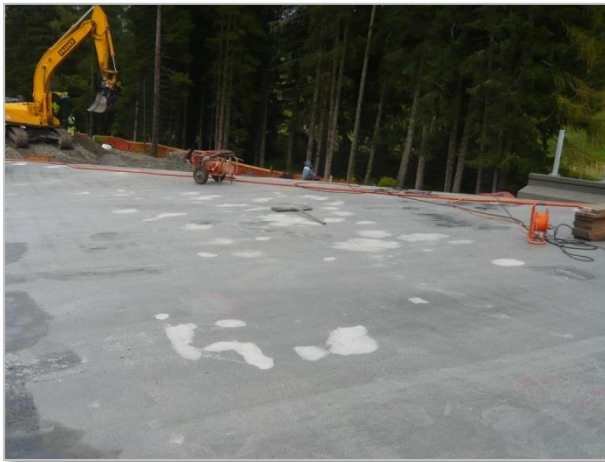
Loakle Kratzspachtelung aus Epoxidharz mit Quarzsandfüllung
