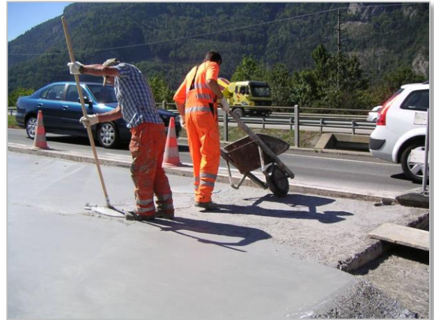
Reprofilierung mit einem Flächenspachtel
