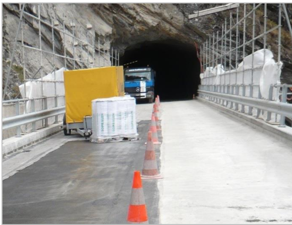
Lagerung der Abdichtungsrollen
