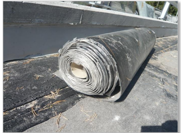
Trennfolie an der Unterseite der PBD-Bahn
