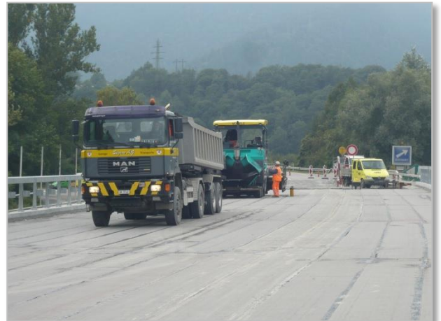
Einbau der Schutz- / Tragschicht
