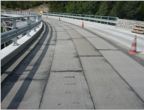
Korrekt eingebrachte Abdichtung
