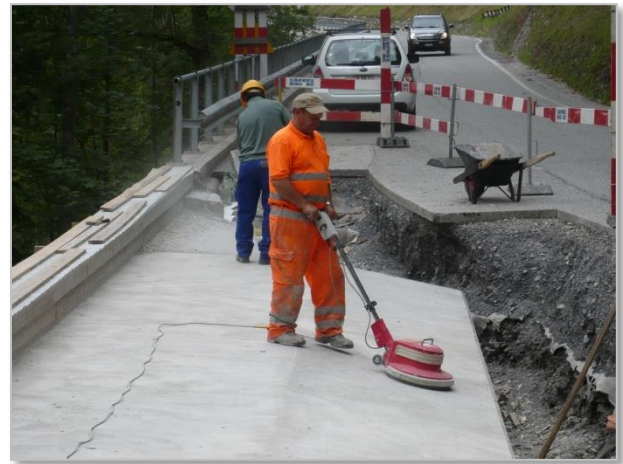
Entfernen der Zementhaut mittels Schleifteller
