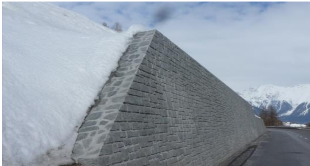
Abb. 3: Mauer ohne Abdeckung, wie Ansicht gemauert
