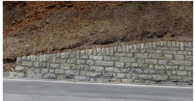
Abb. 4: Mauerabdeckung mit Rollschicht
