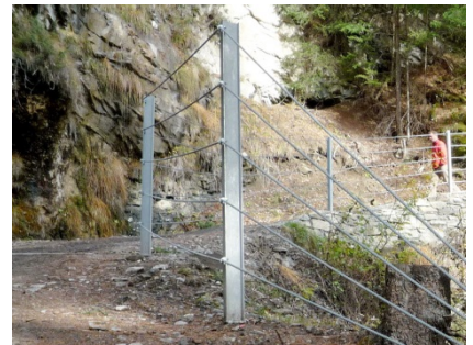
Absturzsicherung für Biker durch minimal 1.30 m hohen Zaun (Stahlprofilpfosten mit Drahtseilausfachung).
