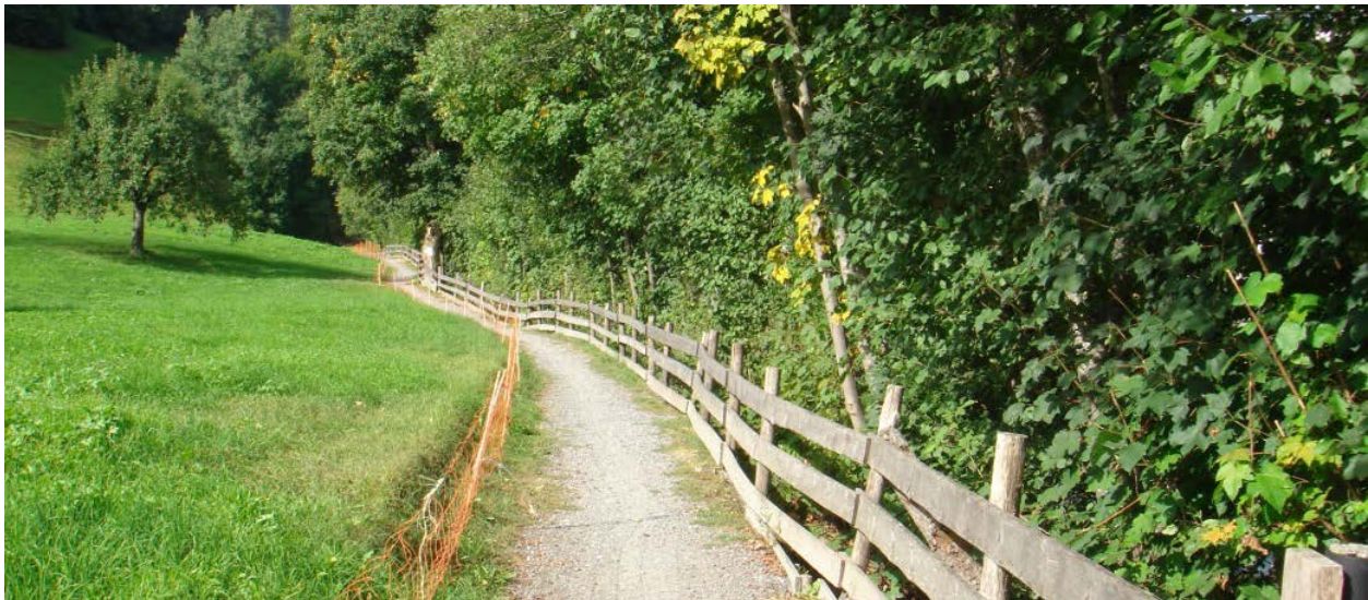
Abb.1: Wanderweg mit Kies ausgebaut (Quelle: STW AG)
