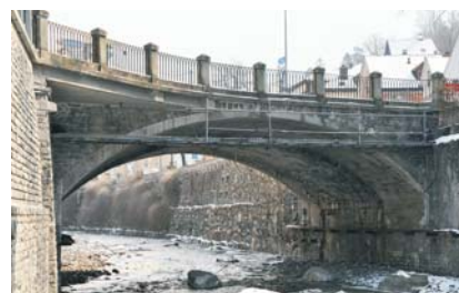
Steingewölbe von 1822 neben Betongewölbe von 1931
