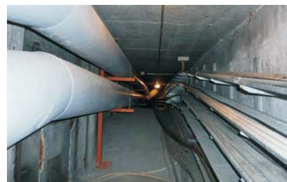
Die Werkleitungen in der Brückenverbreiterung von 1931
