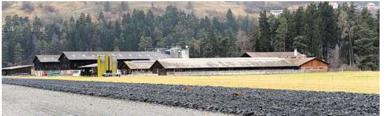
Bald wird Strom produziert: Dem Gutsbetrieb der Justizvollzugsanstalt Realta in Cazis soll ein Biomasse-Kraftwerk angegliedert werden.
