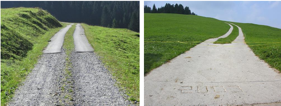
Abb. 20 > Die Wahl des Belags hat eine grosse Auswirkung auf die landschaftliche Wirkung
