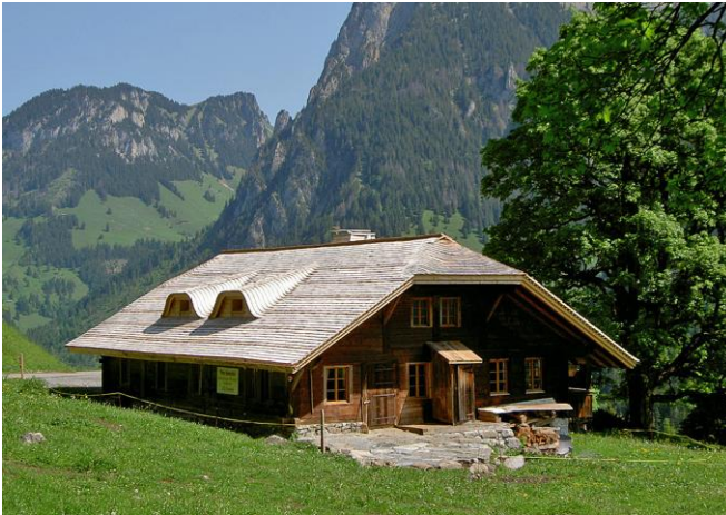
Abb. 14 > Positives Beispiel: Eindeckung und Lukarnen dieses neuen Schindeldachs wurden im ortsüblichen Stil und sorgfältig gestaltet
