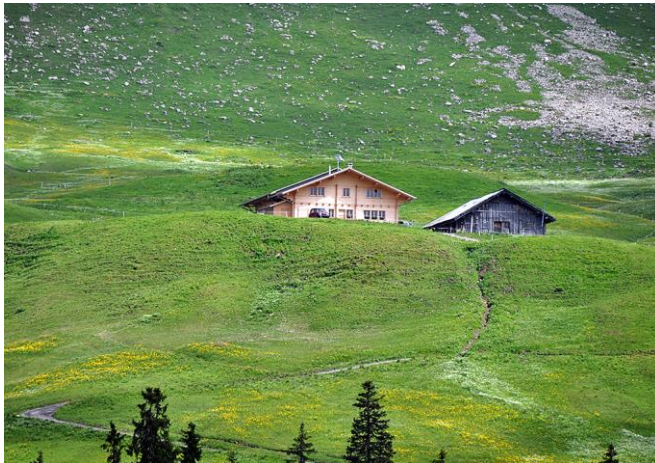
Abb. 12 > Positives Beispiel: Kubatur, Dachform und Fassadengliederung der Neubaute orientieren sich am benachbarten Altbau
