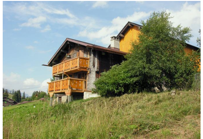
Abb. 13 > Negatives Beispiel: die neuen Balkone wirken aufgesetzt und sind überdimensioniert, die dominierenden Balkone sind funktional ein fremdes Element
