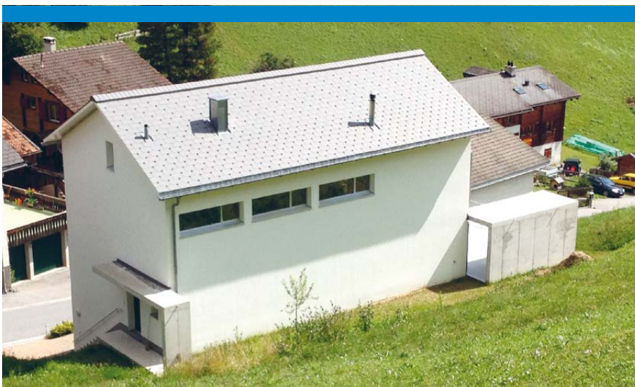
Beispiel für angepasste Fensteröffnungen und Eingangsbereiche zum Schutz vor Lawinen (Foto: S. Margreth, Davos)
