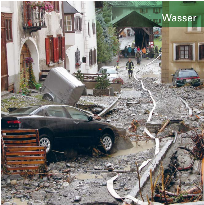
Überschwemmung mit Materialablagerung, Susch (Foto: AWN GR)
