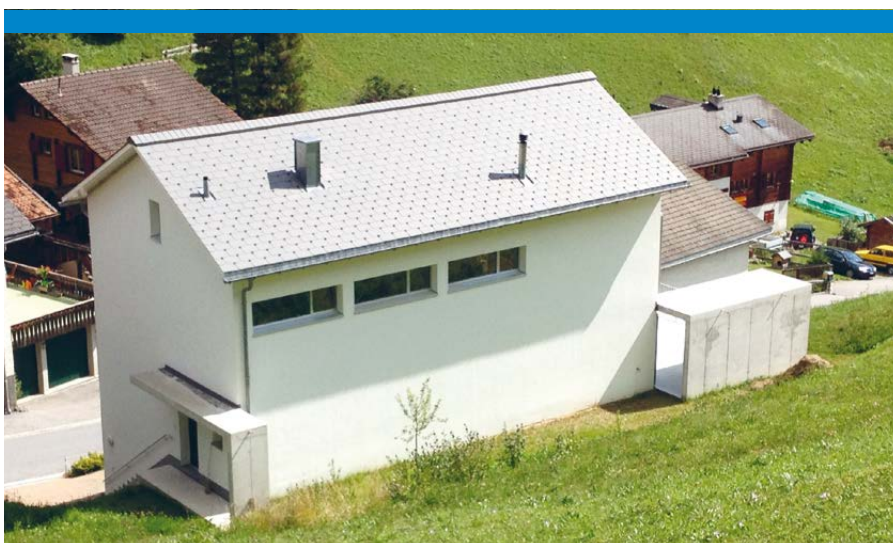
Esempio di aperture adeguate per finestre e aree d'ingresso per la protezione contro le valanghe (foto: S. Margreth, Davos)
