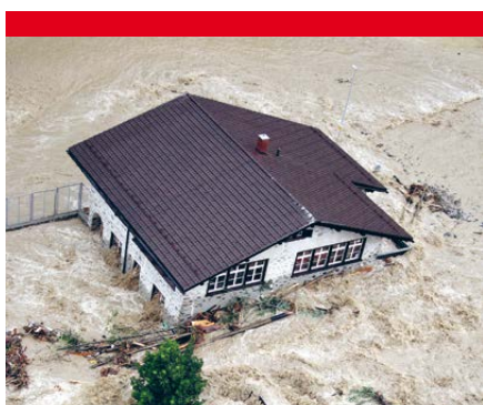
Pericolo elevato dovuto all'acqua (grado di pericolo rosso): evento 2005, Klosters (foto: Foto Schmelz, Klosters)
