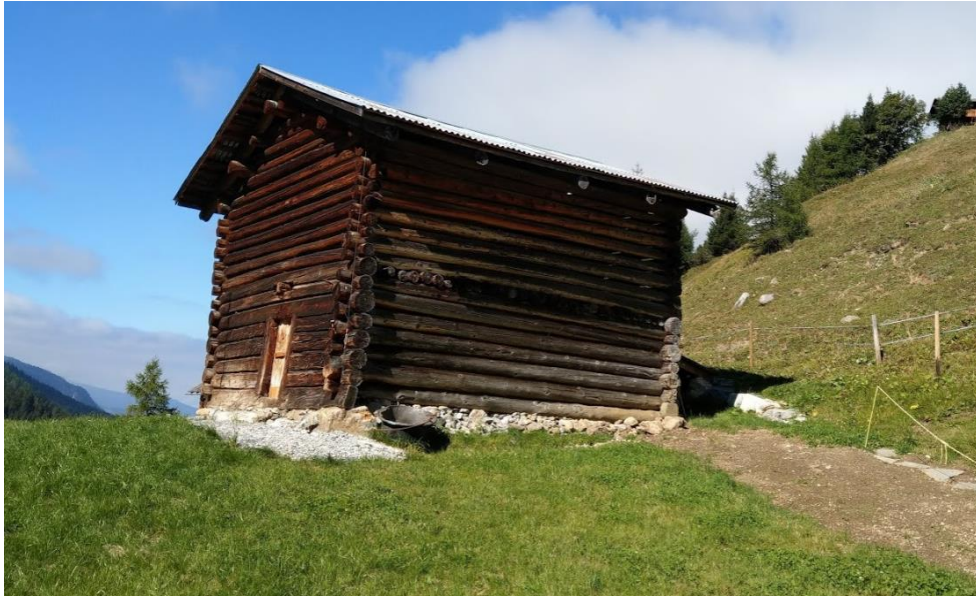
Umzubauender, benachbarter ehemaliger Stall (Quelle: Foto des Eigentümers)
