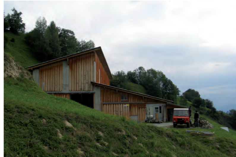
Ruschein Der traufständige Stall liegt parallel zu den Höhenlinien. Das Pultdach auf dem Hauptgebäude verstärkt die talseitige Orientierung.
