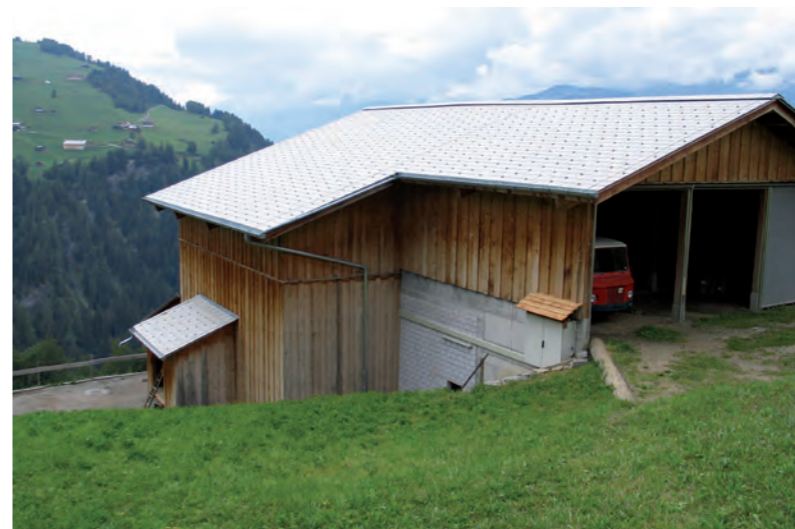
Valendas, Brün Dieses Ökonomiegebäude steht senkrecht zu den Höhenlinien. Die Funktionsflächen sind entsprechend dem Hangverlauf gestaffelt, so dass sie sich auf drei Ebenen verteilen.
