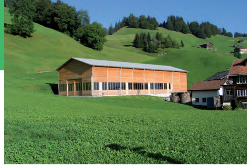
Valzeina Der Stall steht parallel zu den Höhenlinien. Durch die flache Hangneigung und die geschickte Ausrichtung des Gebäudes waren nur geringe Erdbewegungen nötig.
