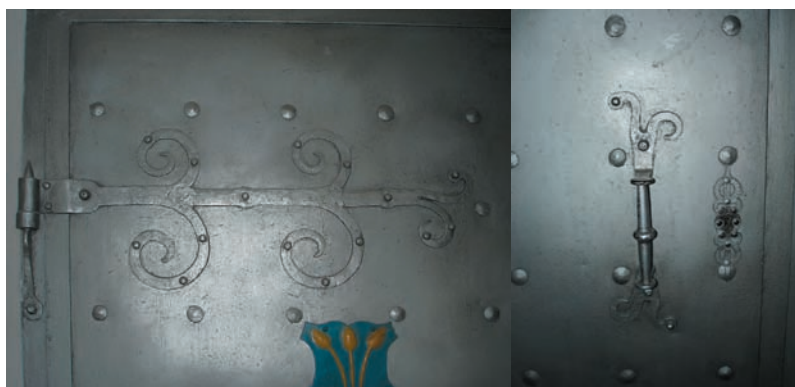
175 - Eisenbeschläge der Archivtür im Erdgeschoss
