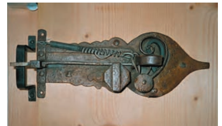
233 - wieder verwendetes barockes Türschloss im Erdgeschoss
