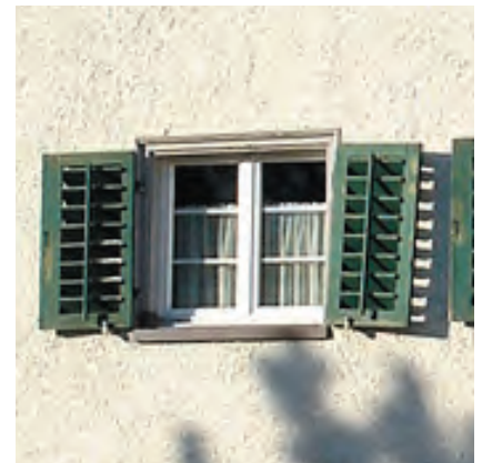
138 - Doppelflügel Fenster, Holzgewände
