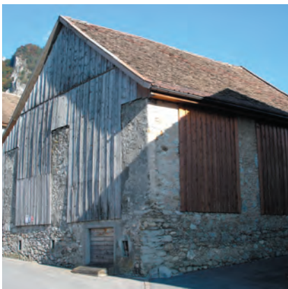
12 - Pfeilerstall mit Holzausfachung
