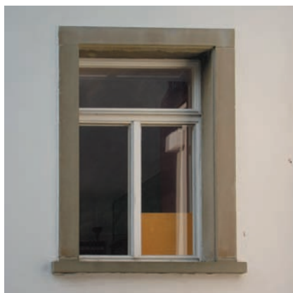
174 - Fenster mit Steingewände
