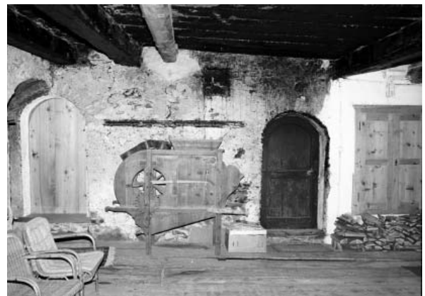
Abb. 89 Cinuos-chel, Haus 269. Russschwärzungen am Türgewände und über dem Kucheneingang sowie an der Sulèrdecke.
