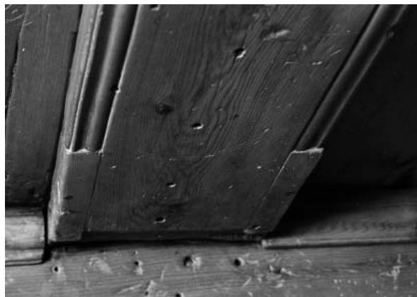
Abb. 66 Susauna, Haus 220. Balkenprofil der flachen spätgotischen Decke der Stube.
