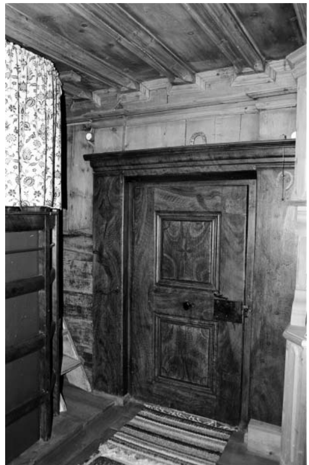
Die Stubentür aus dem beginnenden 19. Jh. und die Balkendecke von 1594. Hinter dem Ofentreppechen ist die unverkleidete Strickkonstruktion zu erkennen.
