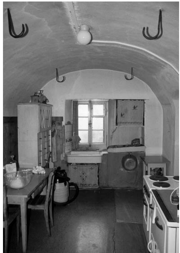
Überwölbte Küche mit eingemauerten Aufhängevorrichtungen
