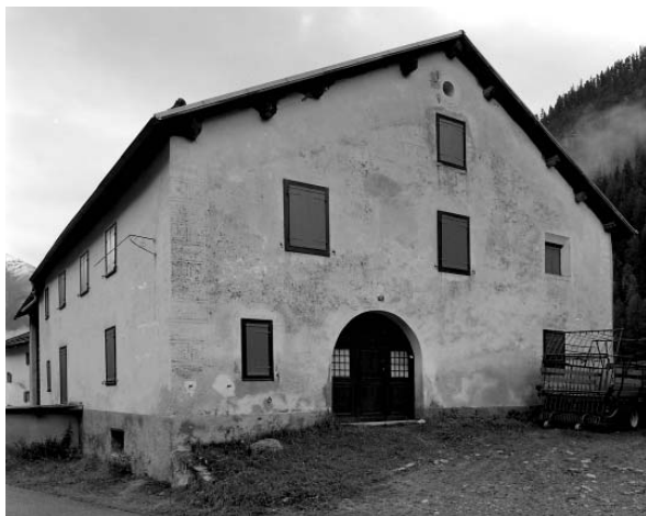
Abb. 35 Susauna, Haus 211. Alle Fenster erneuert und an die Fassade gesetzt, ergibt ein völlig anderes Bild als etwa die Fassade von Su 217 (vgl. Abb. 25).
