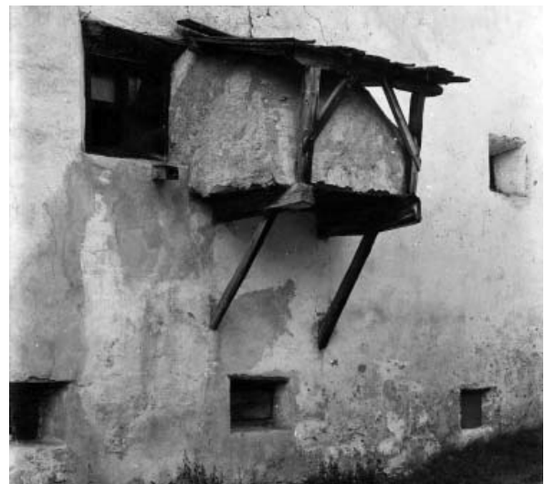
Abb. 32 Cinuos-chel, Haus Denoth (abgerissen), gegenüber Ci 277. Der Aussenbackofen befand sich bei diesem Bau an der Strassenfront und bildete einen markanten Blickfang in der Fassade.
