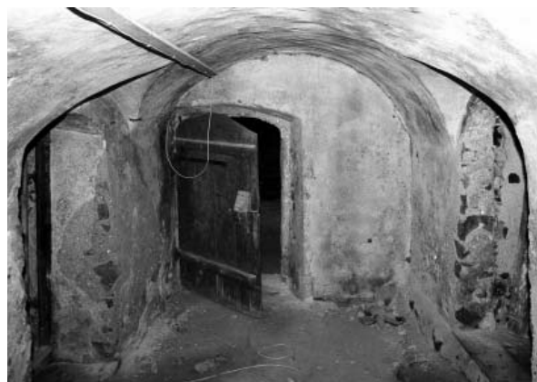
Abb. 101 Cinuos-chel, Haus 269. Tonnengewölbter Küchenkeller. Der Raum erschliesst die beiden anderen Kellerräume, über den Eingängen in die anderen Kellerräume kreuzen Stichkappen das Tonnengewölbe.
