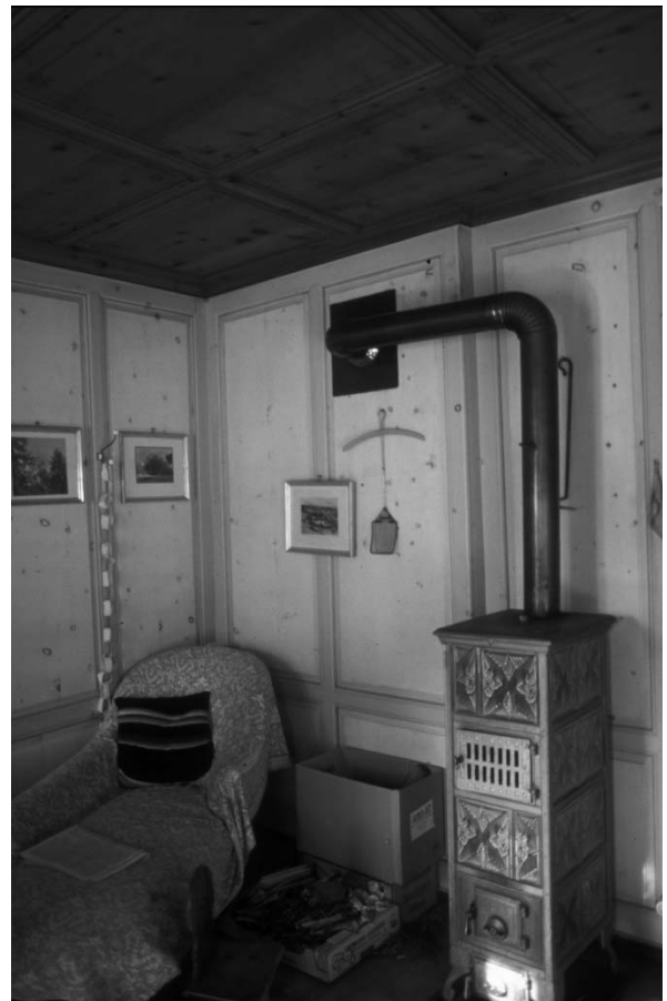
Abb. 75 Cinuos-chel, Haus 273. Stubenaussattung 19. Jh. Die Decke ist klarsichtig lackiert, das Täfer mit hellen Ölfarben bemalt und mit aufgemalten Astaugen verziert.
