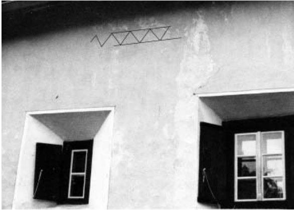
Abb. 37 Cinuos-chel, Haus 259, Detail der Südfront: Unter dem nachträglichen Anstrich ist schwach die spätgotische Ritzdekoration mit aneinandergefügt rechteckigen Dreiecken zu erkennen (speziell hervorgehoben). Es handelt sich um den Rest der Umrahmung eines nachträglich zugemauerten Fensters.
