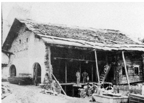
Abb. 23 Ciuos-chel, Haus 277 während des Umbaus 1933. Durch den Abbruch der westlichen Aussenmauer wird der gefügte Strickbau freigelegt, in dem sich Stube und Chabmbra befinden. Auch die alte Dachdeckung mit Brettschindeln ist noch erkennbar.
