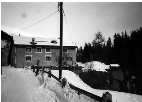
Abb. 35 Susauna, Haus 211. Alle Fenster erneuert und an die Fassade gesetzt, ergibt ein völlig anderes Bild als etwa die Fassade von Su 217 (vgl. Abb. 25).
