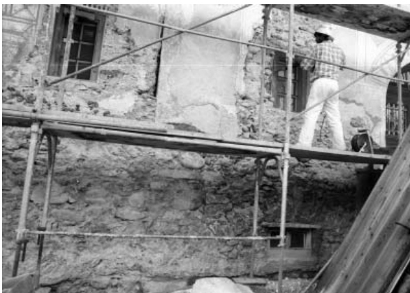
Abb. 56 Cinuos-chel, Haus 262/263, während der Fassadenrestaurierung 1993. Zwischen Wohnteil und Ökonomietrakt ist deutlich eine Baunaht zu erkennen.
