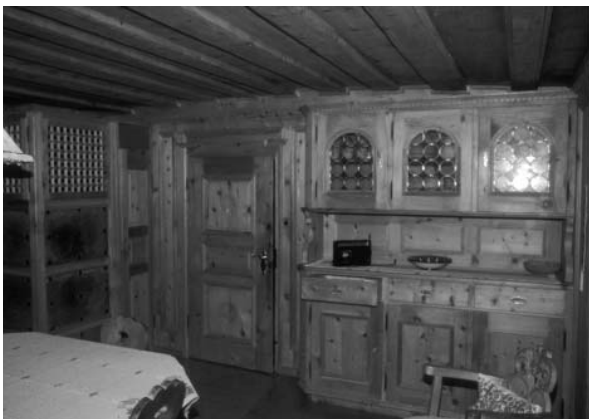
Abb. 65 Cinuos-chel, Haus 280. Spätgotische gewölbte Balkendecke mit verhaltener Profilierung.
