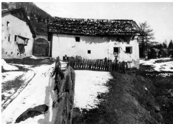
Abb. 34 Cinuos-chel, Haus 277, heute. Die Befensterung geht auf eine Renovation im Jahre 1932 zurück. Man beachte die Vermehrung der Fensteranzahl und die Einheitlichkeit ihrer Anordnung. Der Charakter der Fassade ist völlig verändert. Auch die neue Bedachung gibt dem Bau ein anderes Gepräge.
