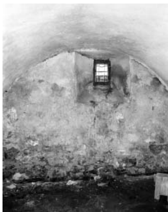
Abb. 100 Cinuos-chel, Haus 269. Tonnengewölbter Chaminadakeller. Boden aus gestampfter Erde.
