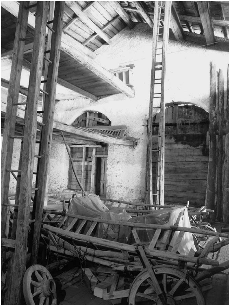
Scheuneninneres mit zweistöckiger Crapenda und freistehenden Leitern - Haus Nr. 44 west
