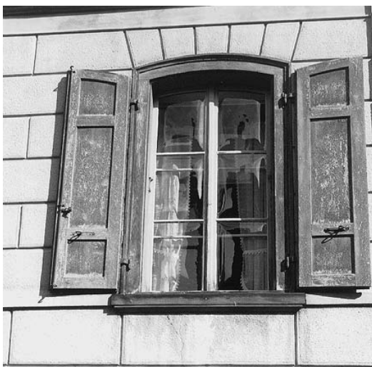
Fenster im Erdgeschoss mit bombierter Verglasung
