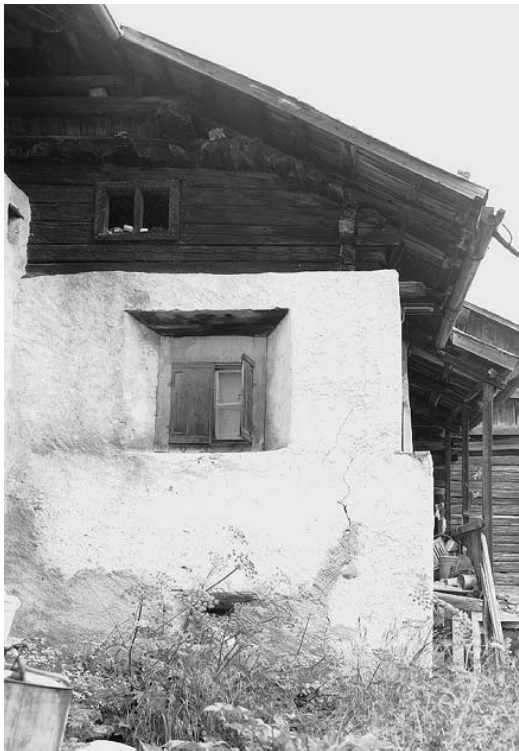
Der Strick im Bereich der Stube ist vorgemauert. Über der Chambrä die abgeheilten Köpfe der Balkendecke
