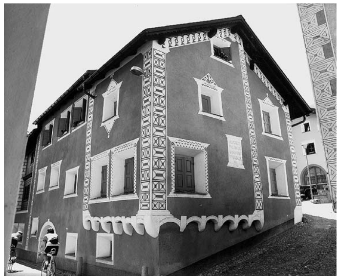
Stubentrakt mit Vormauerung von Südosten
