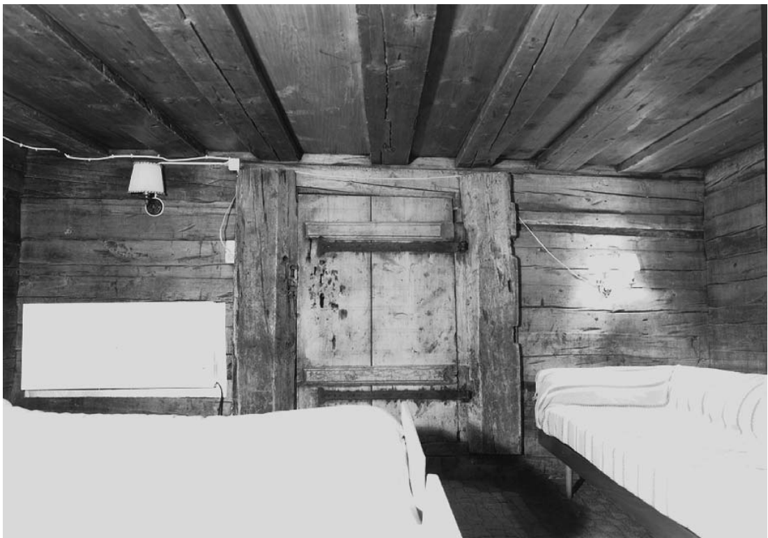
Chambra mit unverzierter Balkendecke und blossen Strickwänden - Haus Nr. 93
