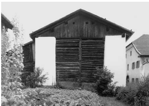
Scheune mit liegenden Balken zwischen Eckpfeilern Haus Nr. 31
