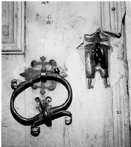
Eisenbeschläge der Stubentüre
