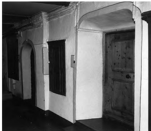
Korbboogenförmiger Stubeneingang und rundbogige Öffnung der Küche
