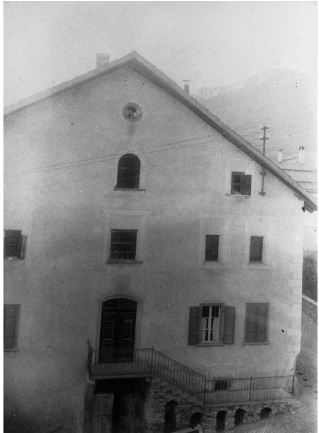
Ostfassade Haus Nr. 44 mit Umgestaltung des Erdgeschoss aus dem späten 19. Jh., nach vorn gesetzte Fenster, Hocheingang und stichbogige Türe. Cuorteinfahrt und Obergeschosse besitzen noch die barocke Dekoration - Aufnahme 1909
