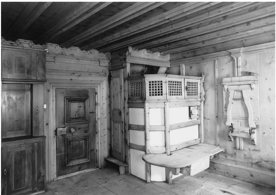
Stube von 1616, gemauerter Ofen mit Treppchen in die Chambrä, Ofenbank und Klapptisch - Haus Nr. 44 west
