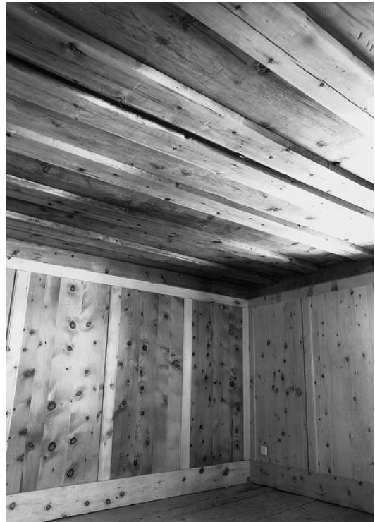
Inneres der Chandra mit unverzierter Balkendecke und altem (rechts) und rekonstruiertem Täger
