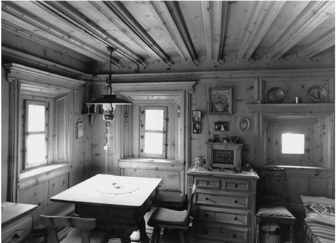
Stube von 1681 mit Balkendecke und Täfer - Haus Nr. 124
