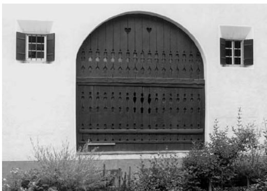
Rundbogige Scheunenöffnung mit Ausfächung in Balusterformen - Haus Nr. 30
