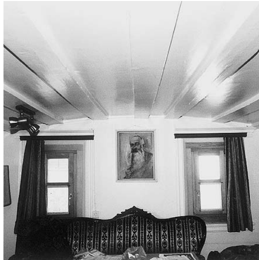
Spätgotische Balkendecke der Stube
