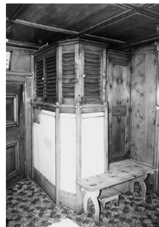
Gemauerter Stubenofen mit Verkleidung und Treppe
