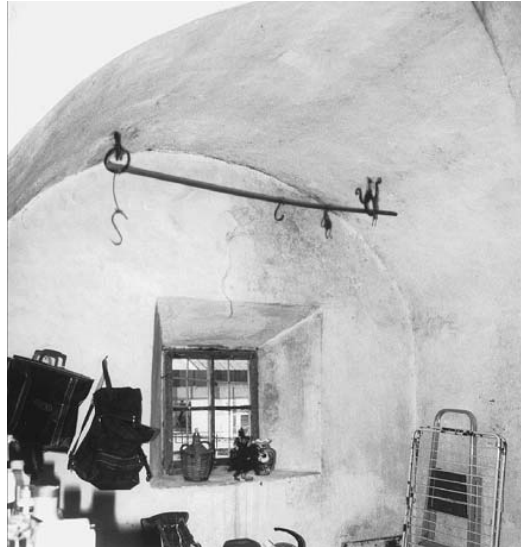
Kreuzgratgewölbe der Chamineda mit Aufhängevorrichtung
