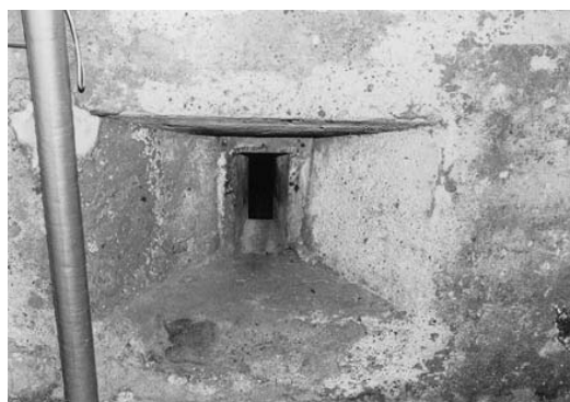
Schartenförmige Lichtöffnung in einem Keller zur Cuort - Haus Nr. 48, vgl. Grundriss KG auf S. 55 unten rechts
