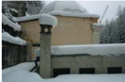
Flachdach mit Oblichtern der Toilettenanlage
