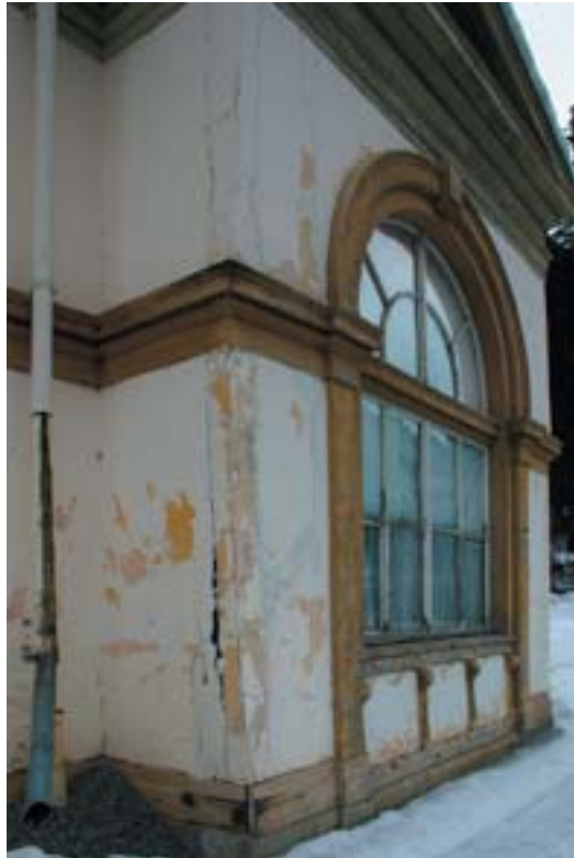
Fassade Eingang Nordost
