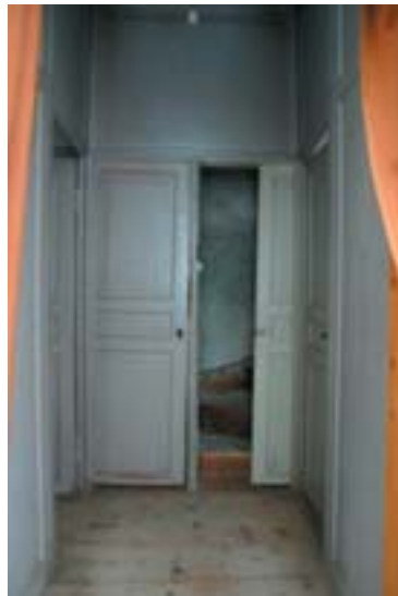
Treppenaufgang in Lagerraum
