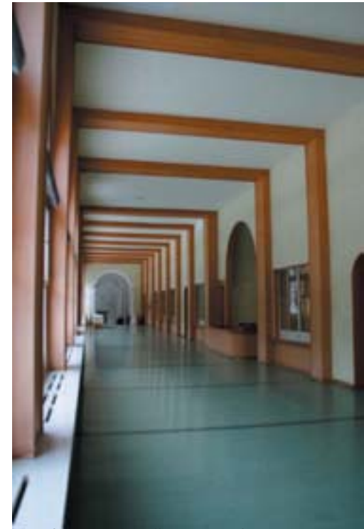
Wandelhalle aktueller Zustand
