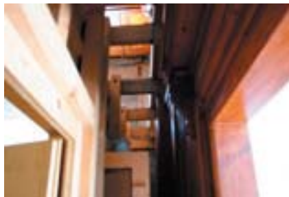
Zwischenraum zwischen alt und neu
