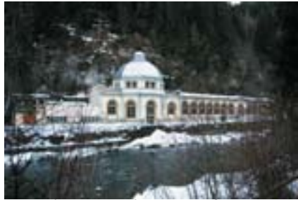
Fassade vom anderen Innufer
