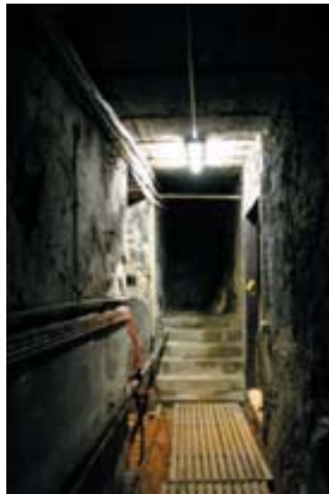
Blick zum Zugang
