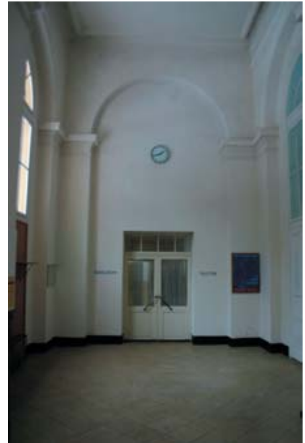
Übergang Zentralbau zu den Gurgelräumen
