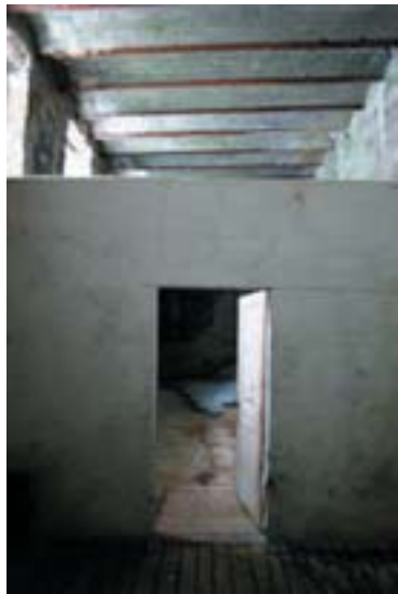
Trennwand mit Tür
