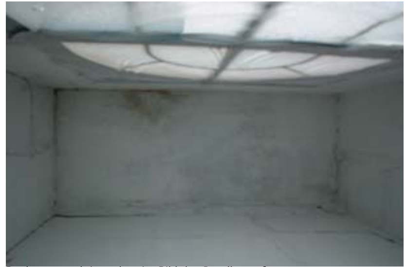
Deckenperspektive, oben im Bild das Rundbogenfenster
