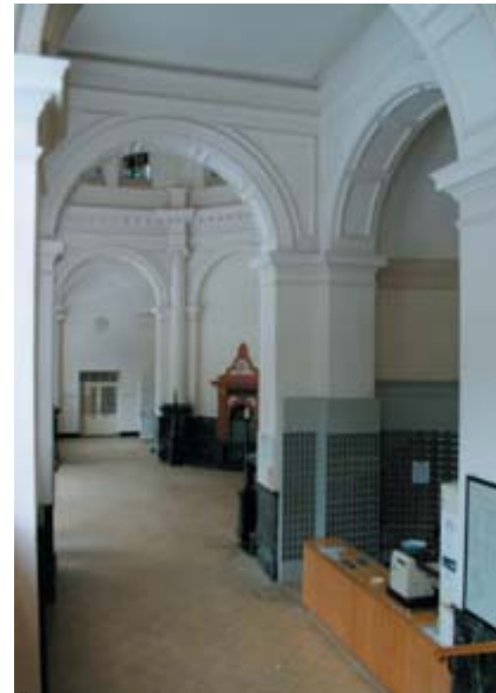
Übergang Rotunde im aktuellen Zustand
