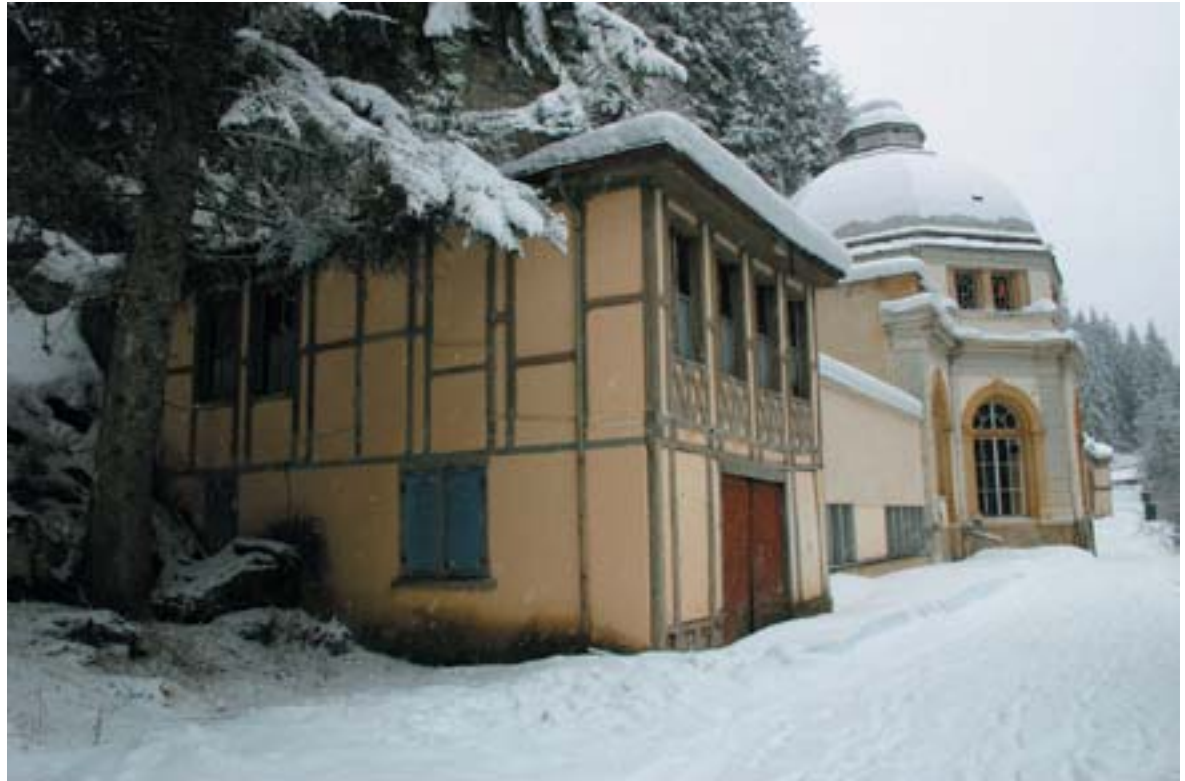
Nordostfassade des Riegelbaus
