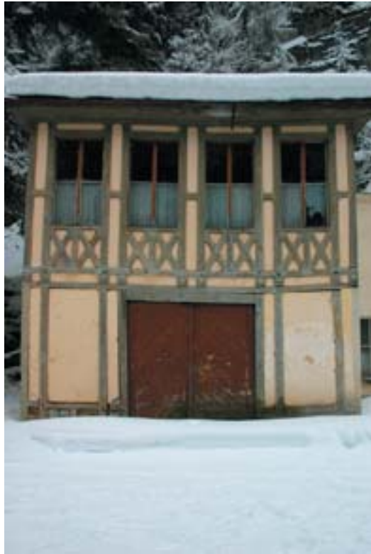
Nordfassade des Riegelbaus
