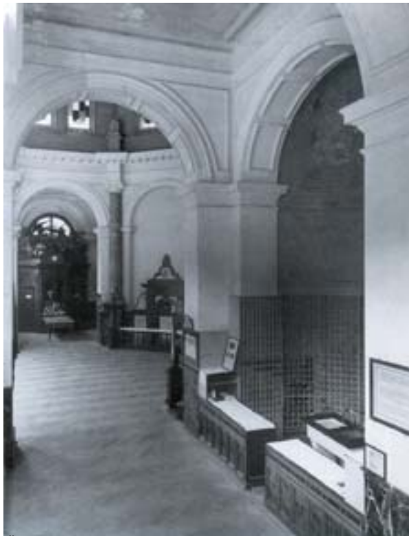
Übergang Rotunde im ursprünglichen Zustand ca. 1890
