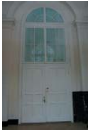
Tür zum Nebengebäude
