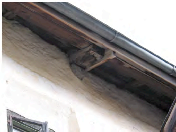
Abb. 244. Detail des Sparrenauflagers
