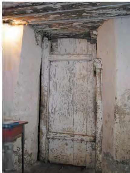
Abb. 135: einfache Drehvorrichtung der Stalltüre
