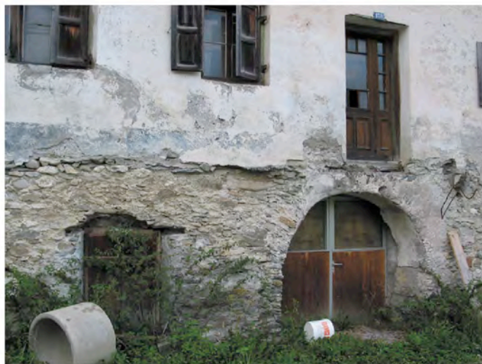
Abb. 243. freigelegter Cuorteingang und abgebrochenes Kellergewölbe
