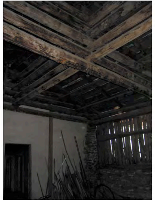
Abb. 78: kreuzförmige, aufgetrölte Rundholz-konstruktion im Heustall
