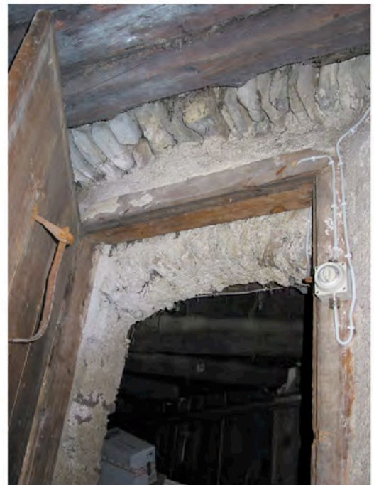
Abb. 51: Doppelt gemauerte Stichbogenöffnung aus Vorratskammer
