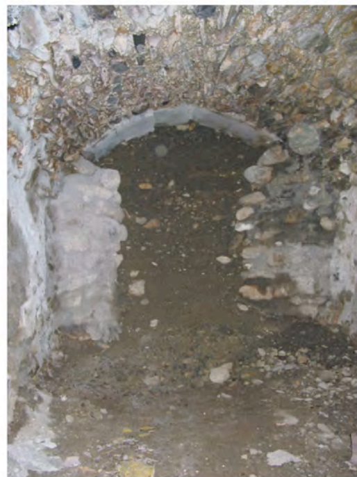
Abb. 89: gewölbter Vorratsraum im Untergeschoss mit Öffnung zum Erdreich
