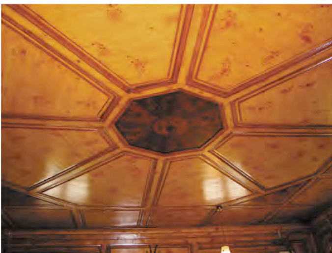
Abb. 9: sternförmige Kassettendecke aus Haus 161 a in Strada
