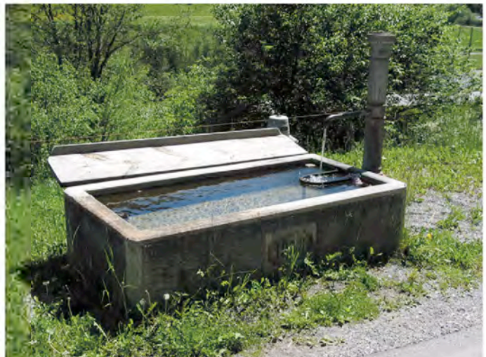
Abb. 15: San Nicola, Waschbrunnen mit einteiligem Betonbehälter und gusseisernem Stahlstock, 1938
