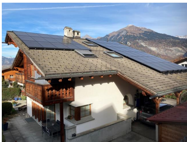
Abbildung 1: Photovoltaikanlage in Igis
