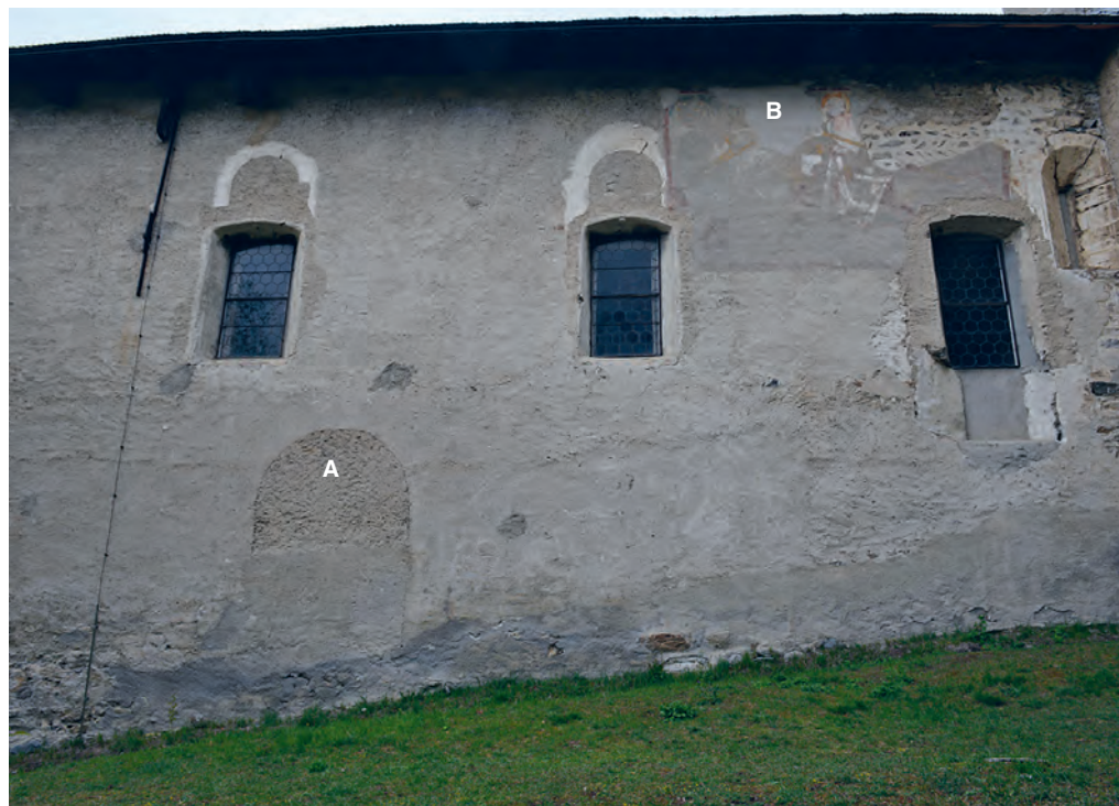
Abb. 6: Rhäzüns, Sogn Gieri. 2019. Südfassade des Schiffes. Teilweise zugemauert sind die älteren, originalen Fenster und der ursprüngliche Haupteingang A . Auf dem originalen, in Pietra-Rasa -Manier verputzten Mauerwerk liegen Reste eines Freskos B , welches den Drachenkampf des Heiligen Georgs darstellt (14. Jahrhundert). Blick gegen Norden.
