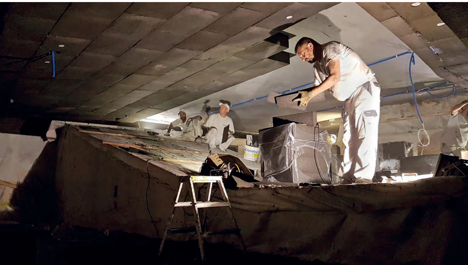
Abb. 4: Chur, St. Stephan. Montage der Foamglassdämmung am 9. Juli 2021.
