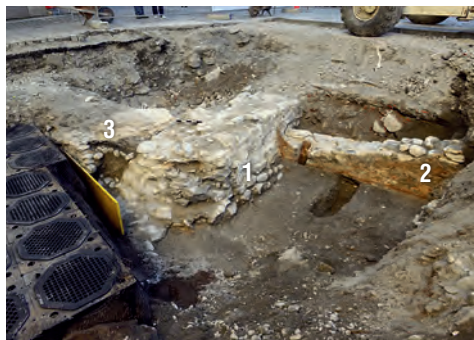
Abb. 3: Chur, Postplatz. Calandagärtli. 2017. Die ältere Stadtmauer 1 (13. Jahrhundert); jüngere anstossende Mauer 2 und ältere Pflasterung auf der Innenseite der Stadtmauer 3 zur Mauer 1 . Blick gegen Südwesten.
