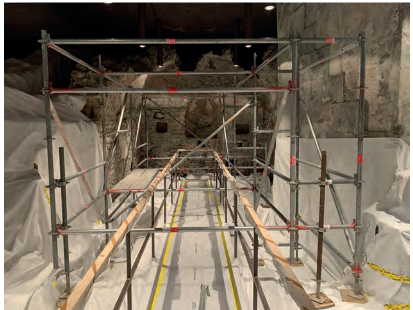
Abb. 3: Chur, St. Stephan. Abdeckung der historischen Mauern mit dampfdurchlässigem Vlies am 22. Mai 2019.
