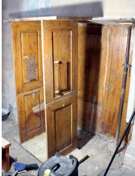
Abb. 3: Val Müstair. Müstair, Klosterkirche. Nordwand. Beichtstuhl B056, partiell demontiert. Die seitlichen Teile wurden entfernt, übrig bleibt der zentrale Teil des Kastens.
