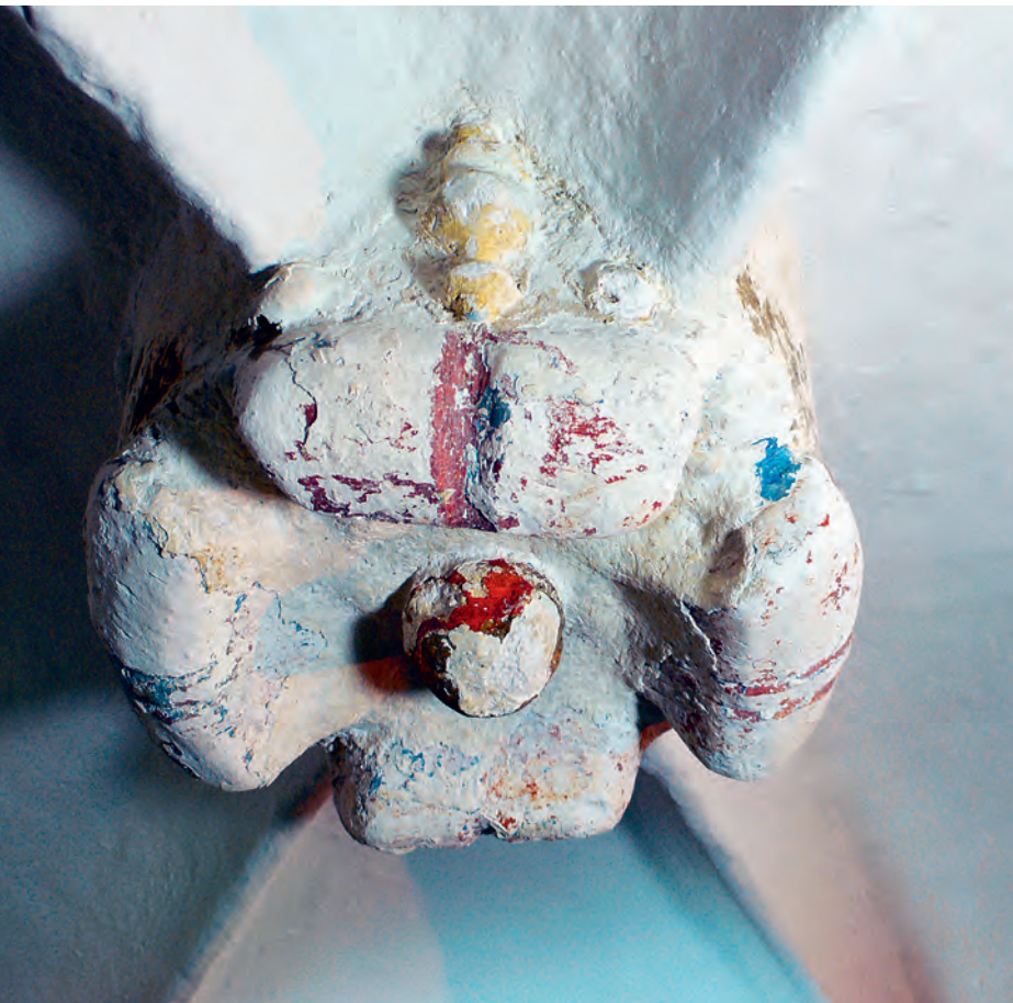
Abb. 18: Val Müstair, Kloster St. Johann in Müstair, Westtrakt, Pfortenhalle 98. Schlussstein im Gewölbe von 1627 aus Stuck mit Fassungsresten aus verschiedenen Zeiten. Über der ersten Schicht auch Reste von Schwalbennestern.
