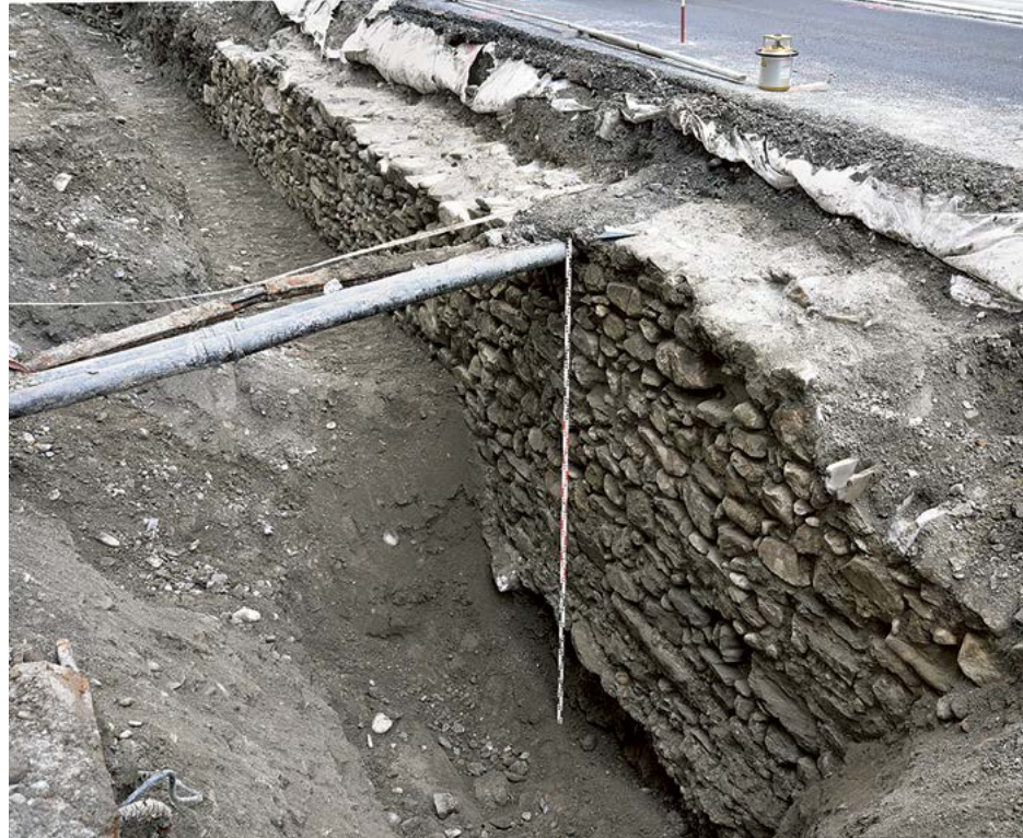
Abb. 2: Chur, Grabenstrasse. 2021. Ausschnitt der freigelegten «Contrescarpe-Mauer», die gegen Nordwesten in den Baugrubenrand übergeht. Für einen Kanalanschluss wurde hier bis unter die Mauerunterkante abgeteuft. Blick gegen Westen.
