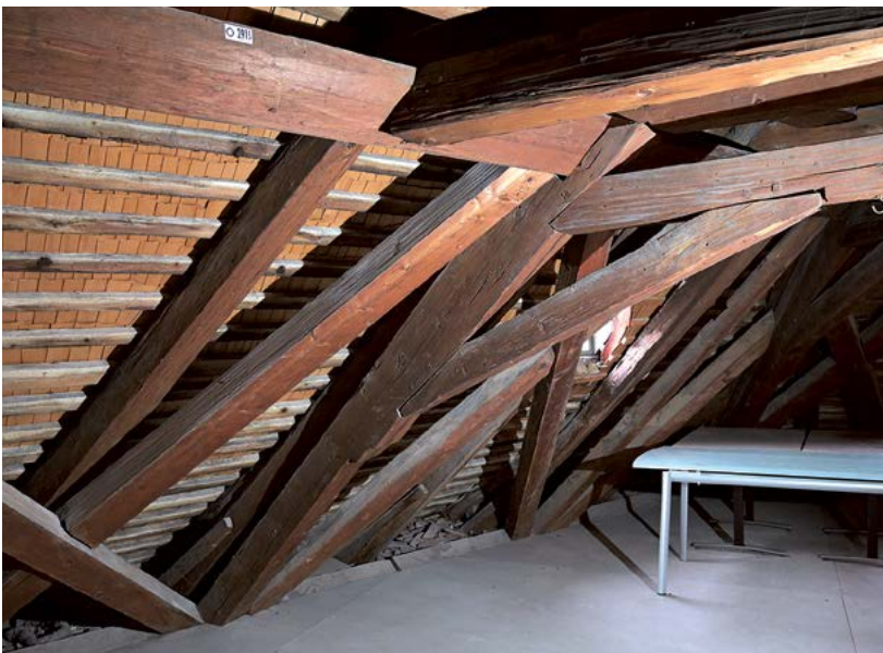
Abb. 9: Chur, Hof, Bischöfliches Schloss, Westtrakt. Liegender Dachstuhl von 1732. Die Kopfstrebe ist nicht mehr wie im 17. Jahrhundert an der Stuhlsäule und dem Spannriegel angeblattet, sondern durch eine Verzapfung mit Auflageversatz befestigt. Blick gegen Süden.
