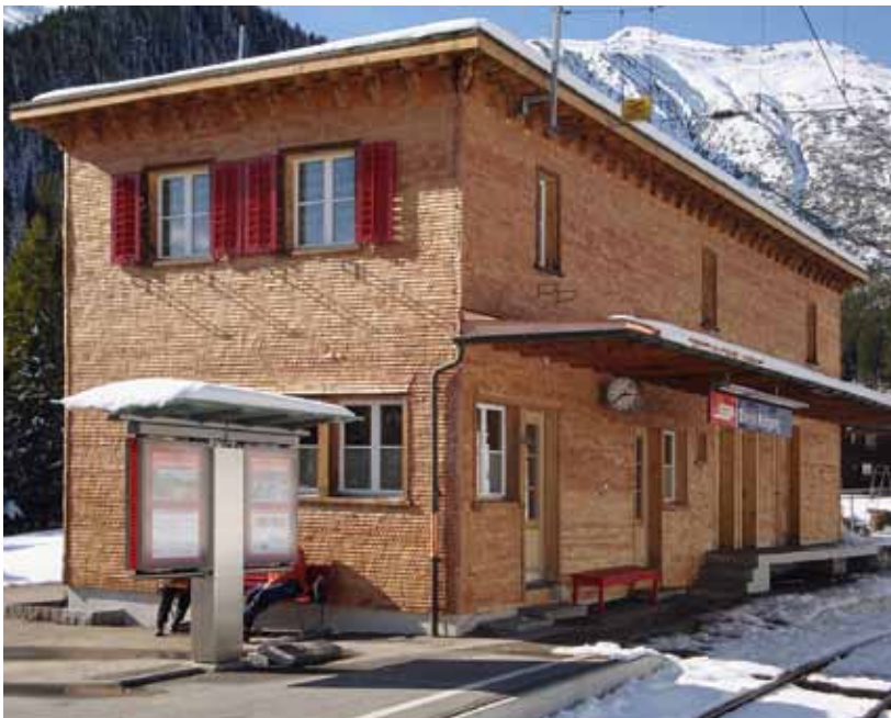
Abb. 136: Davos, Wolfgang, Bahnstation der RhB, Nr. 471. Ansicht von Osten nach der Erneuerung des Schindelschirms.
