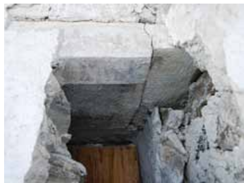
Abb. 61: Val Müstair, Müstair, Kloster St. Johann. Heilighauskapelle, Westflanke der Nordapsis. Originale Obergeschosstüre mit Marmorsturz und ausgerissenen Laibungssteinen; Rückseite der Schranknische. Blick nach oben gegen Osten.
