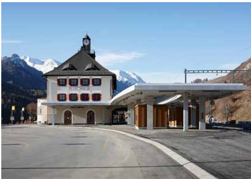
Abb. 148: Scuol, Aufnahmegebäude der RhB, Nr. 498. Ansicht von Osten mit dem neuen Mittelperron.
