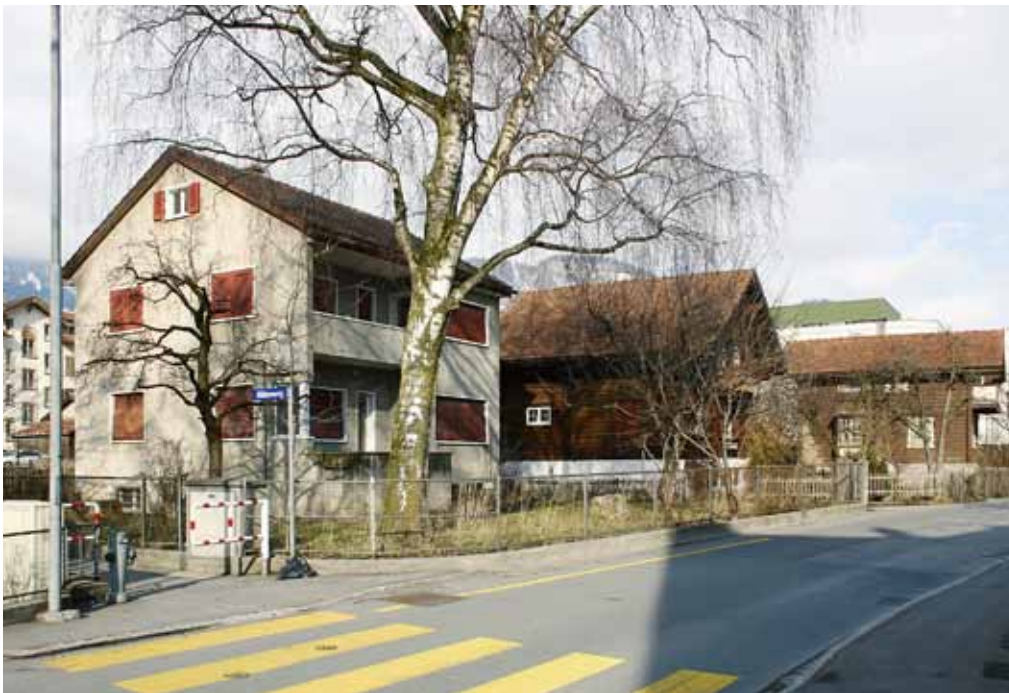
Abb. 169: Igis, Landquart, Abbrüche im Raum Bahnhofstrasse. Die Wohnhäuser Nr. 311, 312 und 312A an der Zollstrasse vor dem Abriss. Ansicht von Südwesten.
