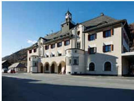
Abb. 149: Scuol, Aufnahmegebäude der RhB, Nr. 498. Südostfassade.
