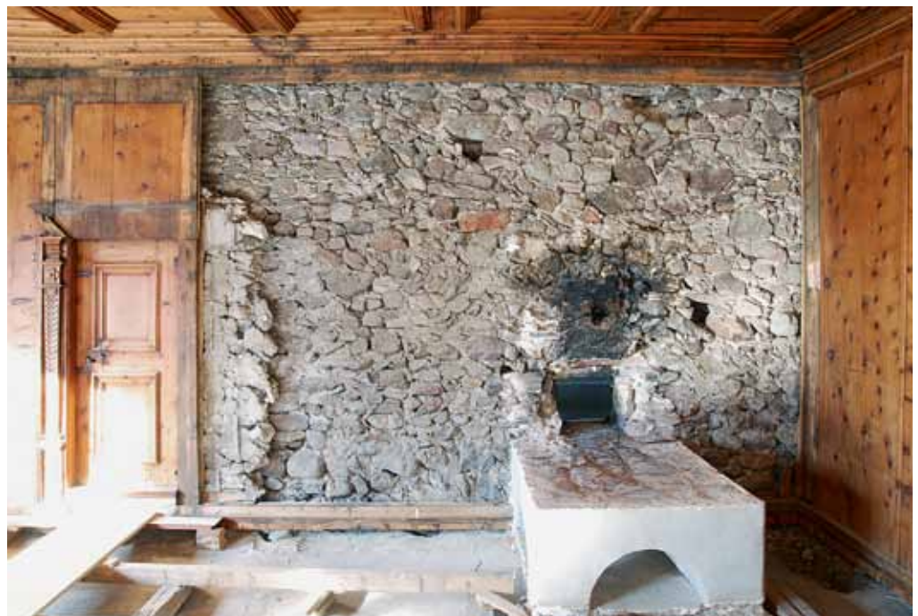
Abb. 55: Val Müstair, Müstair, Kloster St. Johann. Norpertrakt 2. Obergeschoss, Fürstenzimmer 143. Ehemalige nördliche Giebelwand mit Dachschräge; die darauf liegenden Lattenlöcher gehören zu einer Dachdeckung von 1405. Blick gegen Norden.
