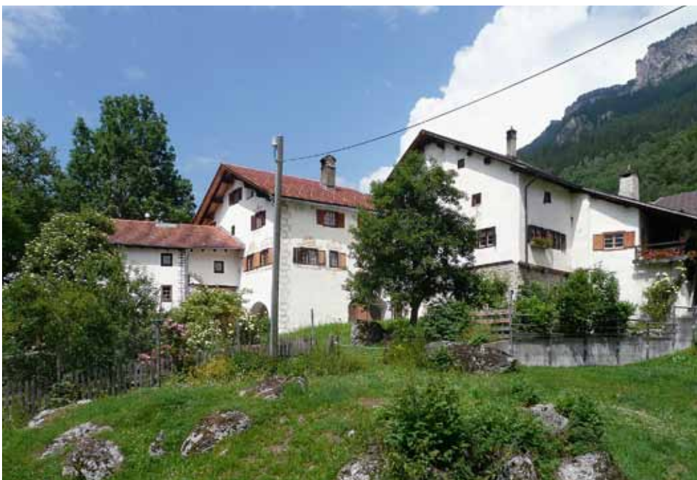
Abb. 162: Zillis-Reischen, Reischen, Wohnhaus, Nr. 144. Der Cajafashof, bestehend aus den Häusern Nr. 142, 144 und 145.
