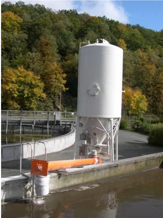
Abbildung 1: Kreidezugabe auf der Kläranlage Freudenberg
