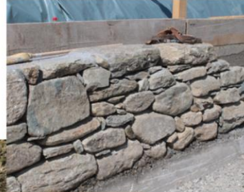
Trockenmauern am Splügenpass
