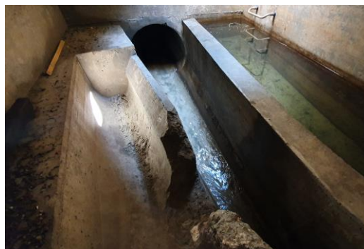
Abbildung 2: Begehung einer Hochwasserentlastung
