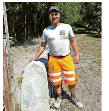
Igl magna-construcziun Luca Delle Cave mussa igl crap digl frunt digl nov mir schetg.
