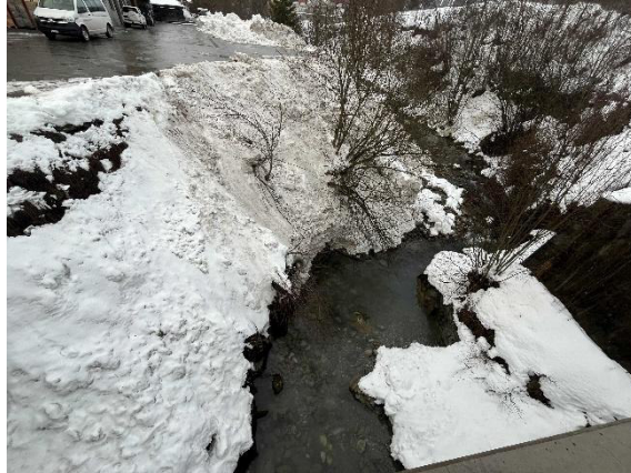
Schneedeponie oberhalb der Brücke über den Flembach.
