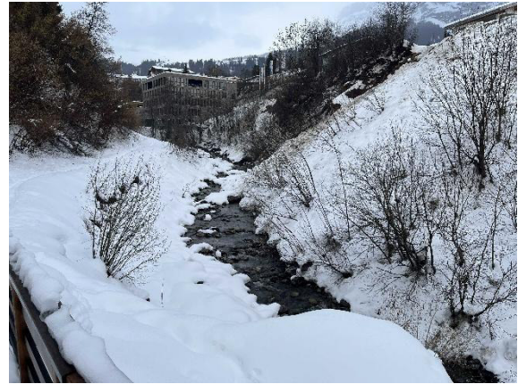
Blick aufwärts zur KW Zentrale Flimselectric
