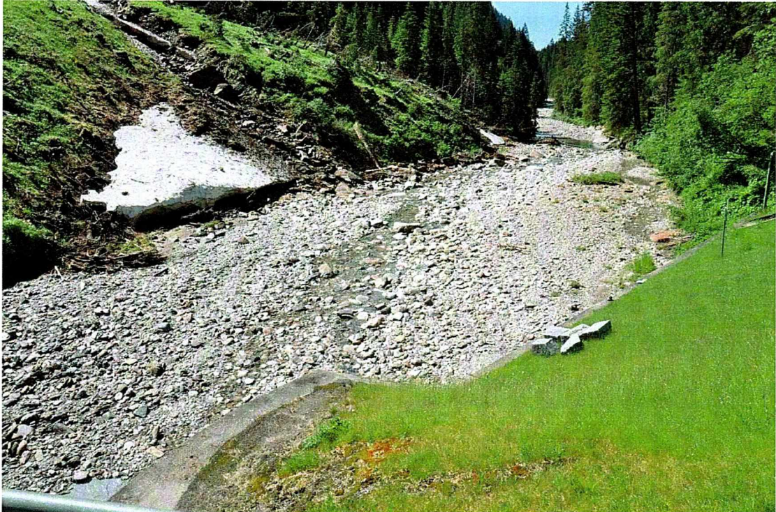
Abb. 5.4 Calancasca ab Fassung Valbella mit Blickrichtung flussabwärts, Foto vom 3. September 2014 (ohne Restwasserdotierung).
