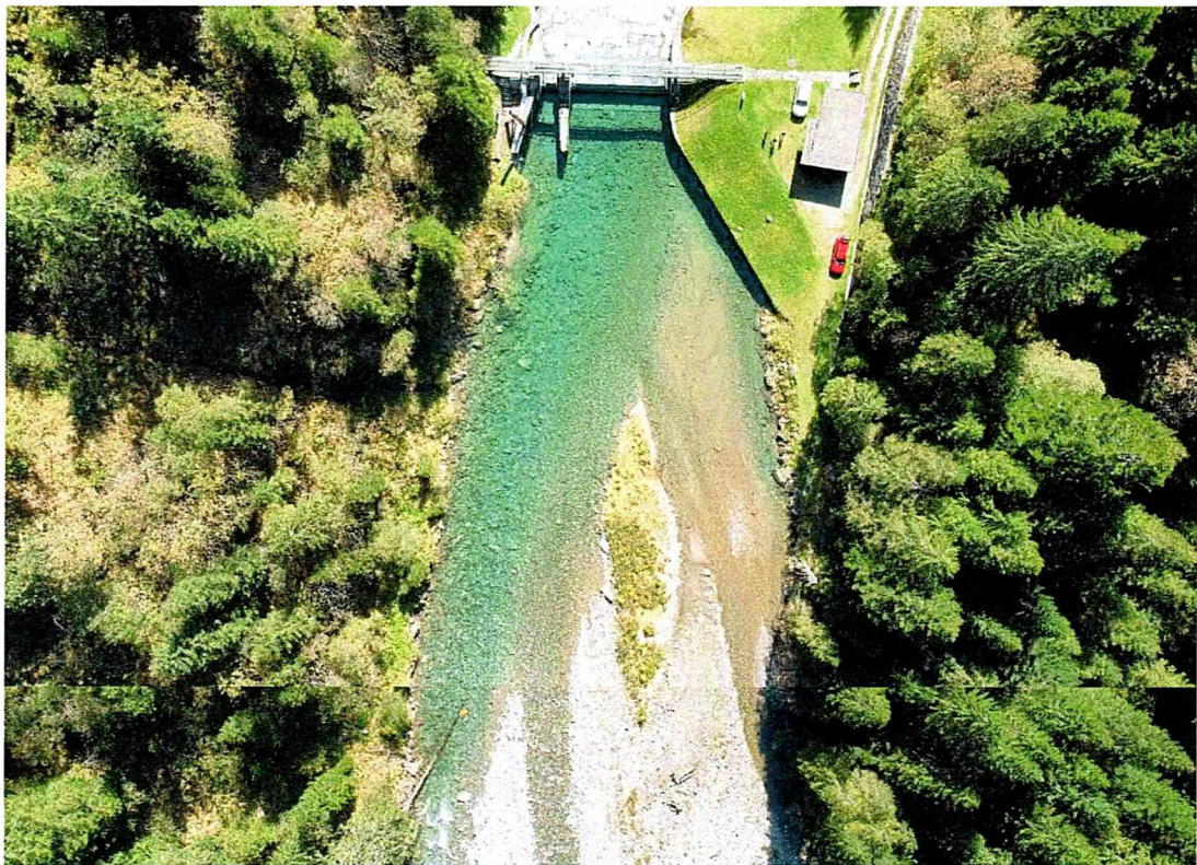
Abb. 5.1 Fassungsstauraum Valbella aus der Vogelperspektive vom 27. September 2023. Blick in Fließrichtung
