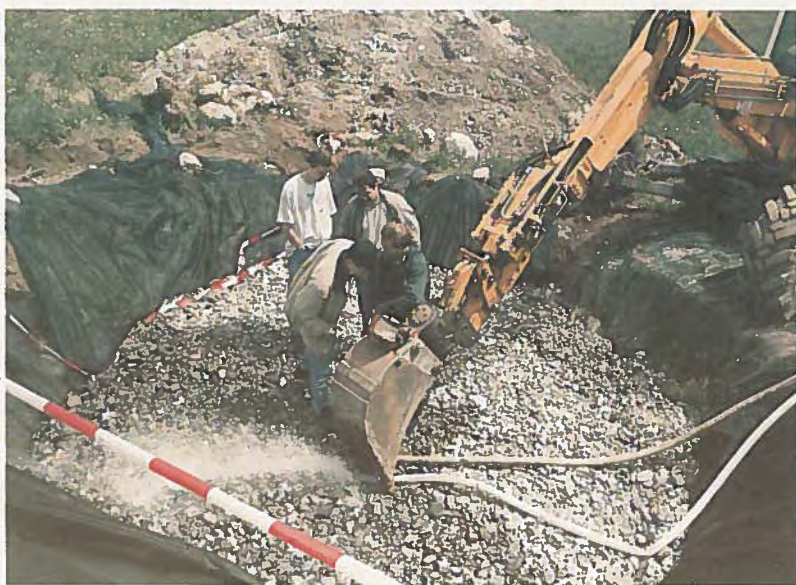
Durchführung eines Versickerungsversuchs nach dem Einbau des Kieskörpers
