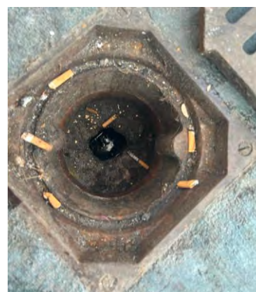
Abbildung 7: Entwässerung des Churer Postautodecks; in regelmässigen Abständen finden sich kleine Abwasserschächte in denen sich zum Teil Wasseransammlungen finden lassen.
