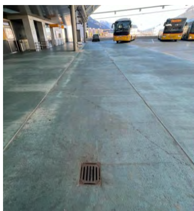
Abbildung 7: Entwässerung des Churer Postautodecks; in regelmässigen Abständen finden sich kleine Abwasserschächte in denen sich zum Teil Wasseransammlungen finden lassen.
