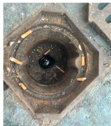
Figura 8: Smaltimento delle acque di scarico nella stazione coperta dell'Autopostale a Coira; a distanze regolari sono presenti dei piccoli pozzetti di scarico, nei quali in parte si accumula acqua stagnante.
