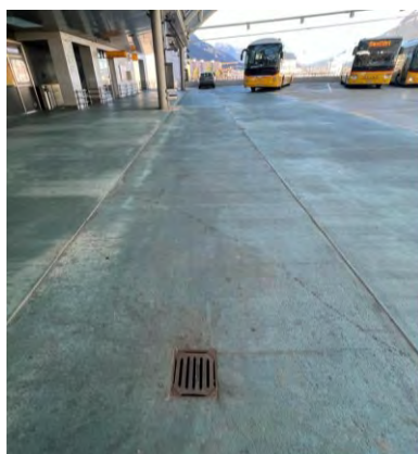
Figura 8: Smaltimento delle acque di scarico nella stazione coperta dell'Autopostale a Coira; a distanze regolari sono presenti dei piccoli pozzetti di scarico, nei quali in parte si accumula acqua stagnante.
